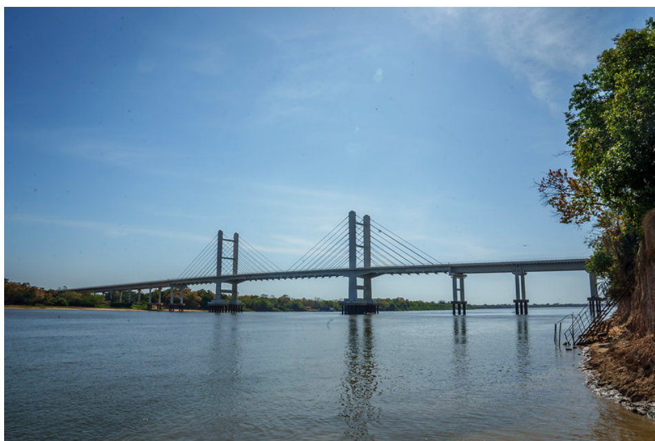
Vistoria às obras sobre a ponte do Rio Araguaia. Crédito: Michel Corvello.
