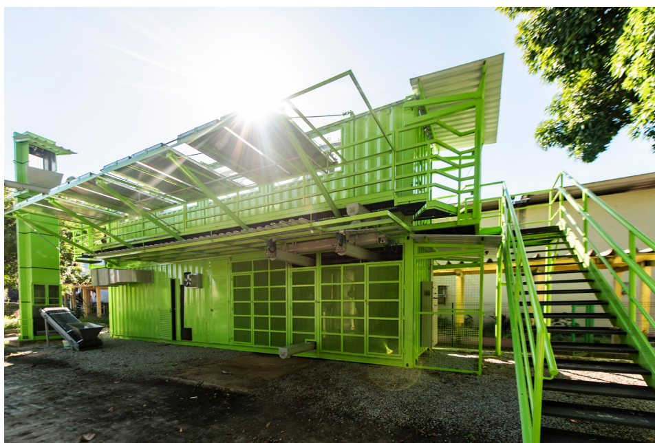
Usina-modelo de biogás da Cagece gera energia renovável e eficiente a partir de sobras de compostos das estações de tratamento de esgoto. Crédito: Arquivo Cagece
