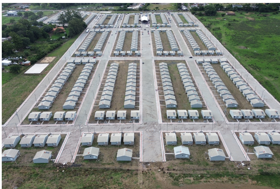
Obras de conjunto habitacional do Programa Minha Casa, Minha Vida com painéis de energia solar em Uruguaiana/RS. Créditos: Ministério das Cidades
