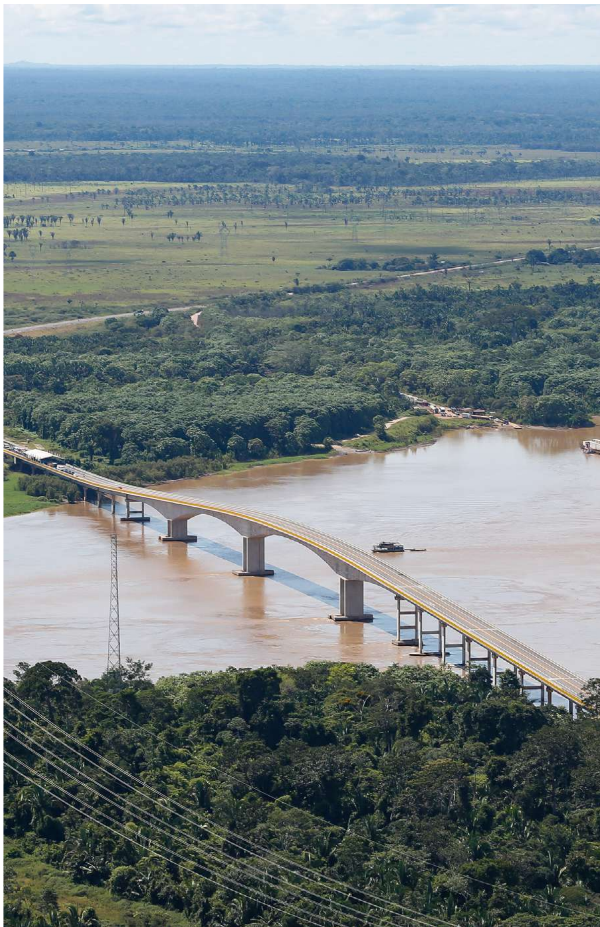
Ponte sobre o Rio Madeira, BR-364, Distrito de Abunã, RO. / Foto: Anderson Riedel/PR
