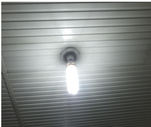
Figura 22. Foto de iluminação ineficiente de uma área de trabalho no edifício 12, em que foram registrados níveis de iluminância muito baixos.
