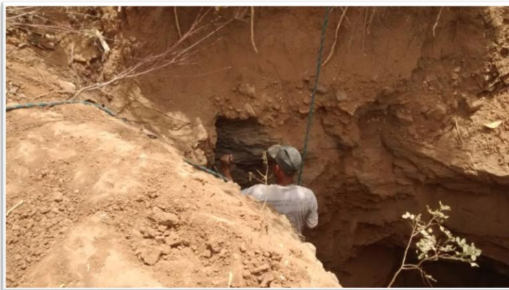
Foto 6. Frente de lava de minério primário utilizando desmonte manual
