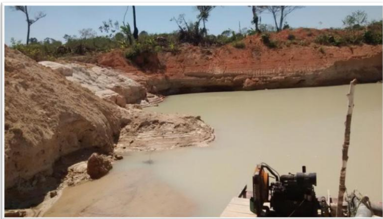
Foto 12. Sistema de bombeamento de água para formação da polpa na lavra e posterior concentração em calhas rifladas
