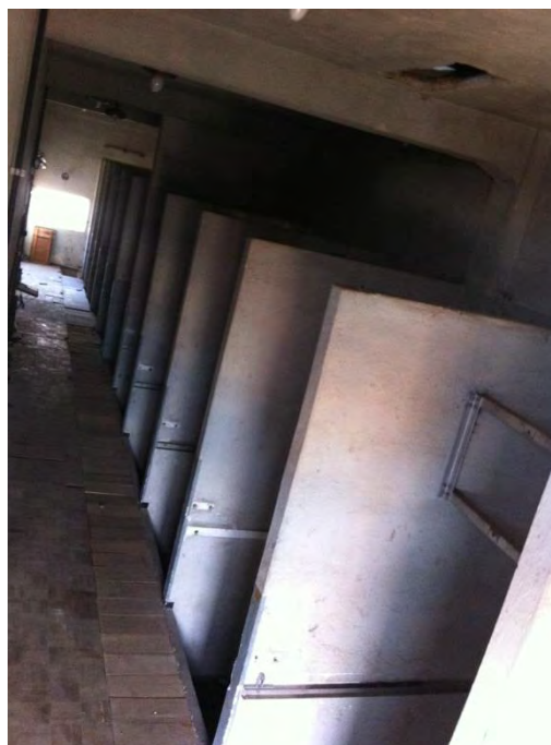
Foto 10 – Vista do interna do galpão (compartimento norte). O local é formado por 13 cabines seccionadoras.
