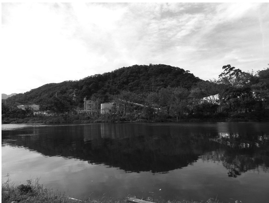
Fonte: Ecologistas en Acción, 2012. Carbocloro (Cubatão – São Paulo). Vista da planta do outro lado do Rio Cubatão.
