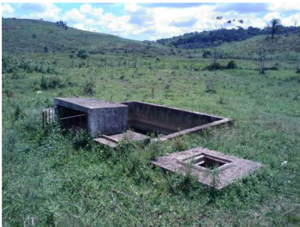
Figura 49 - Central de tratamento de líquidos do aterro de Rio Formoso antes da recuperação
