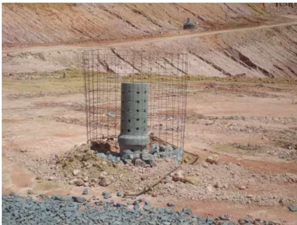
Figura 64 - Dreno de biogás do aterro de Jaboatão dos Guararapes (Fonte: Levantamento em campo - Itep, 2011)
