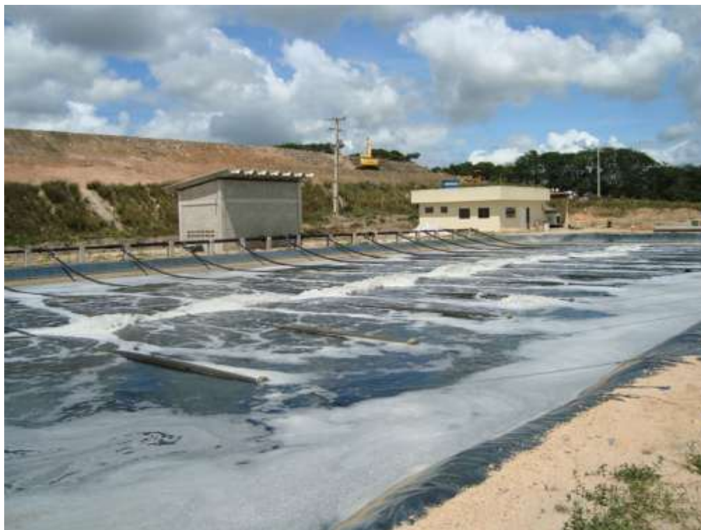
Figura 58 - Estação de tratamento de lixiviados do aterro de Igarassu (Fonte: Levantamento em campo – Itep, 2011)
