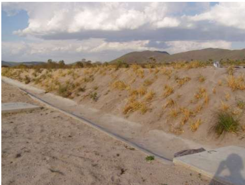
Figura 16 - Vista da célula em operação e do sistema de drenagem de águas pluviais (Fonte: Geosistemas – Março, 2006)
