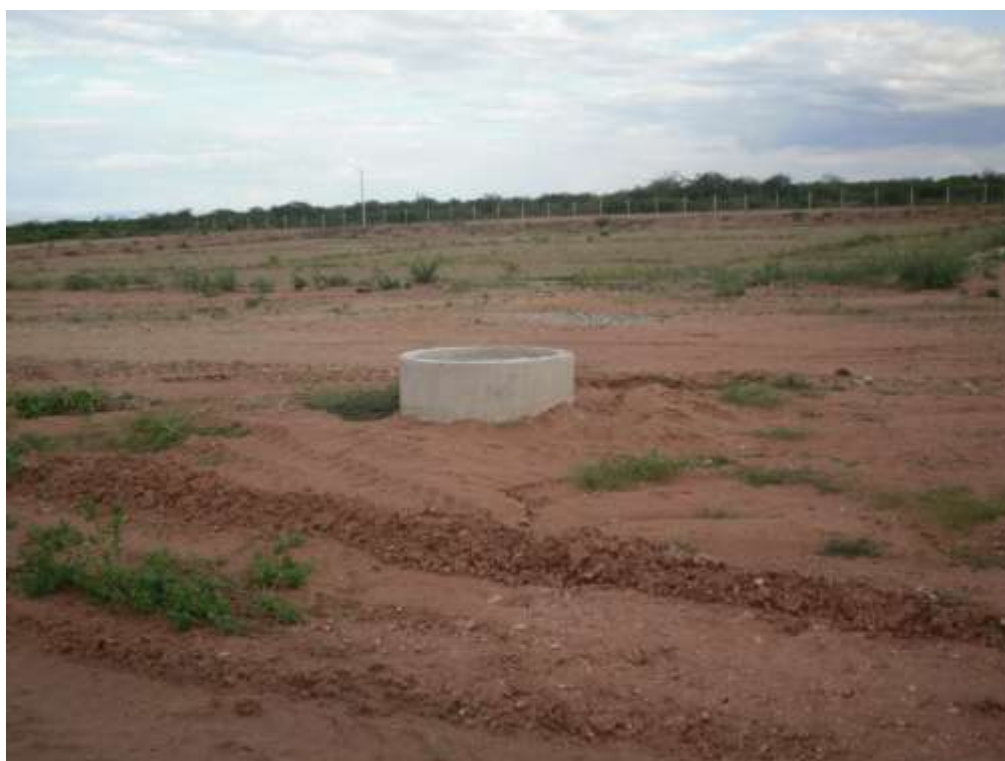
Figura 10 - Dreno de gás do aterro sanitário do município de Ibimirim (Fonte: Levantamento direto em campo - ITEP, 2011)
