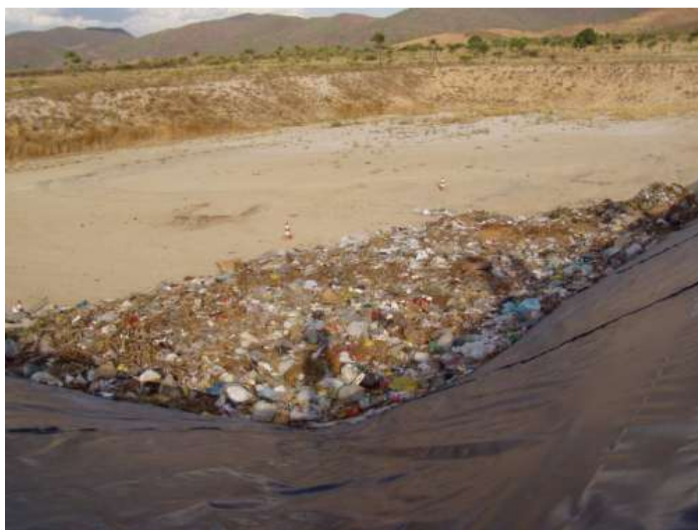
Figura 17 - Célula em operação do aterro sanitário de Iati (Fonte: Geosistemas – Março, 2006)
