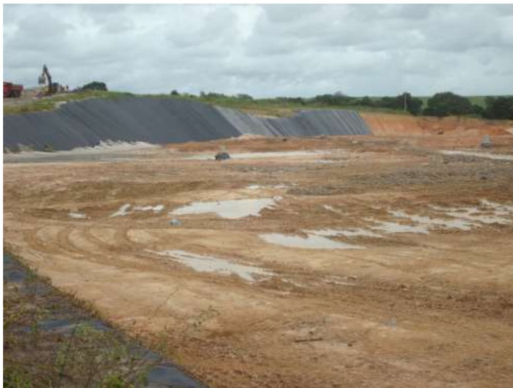
Figura 56 - Célula e dreno de gás do aterro de Igarassu (Fonte: Levantamento em campo – Itep, 2011)
