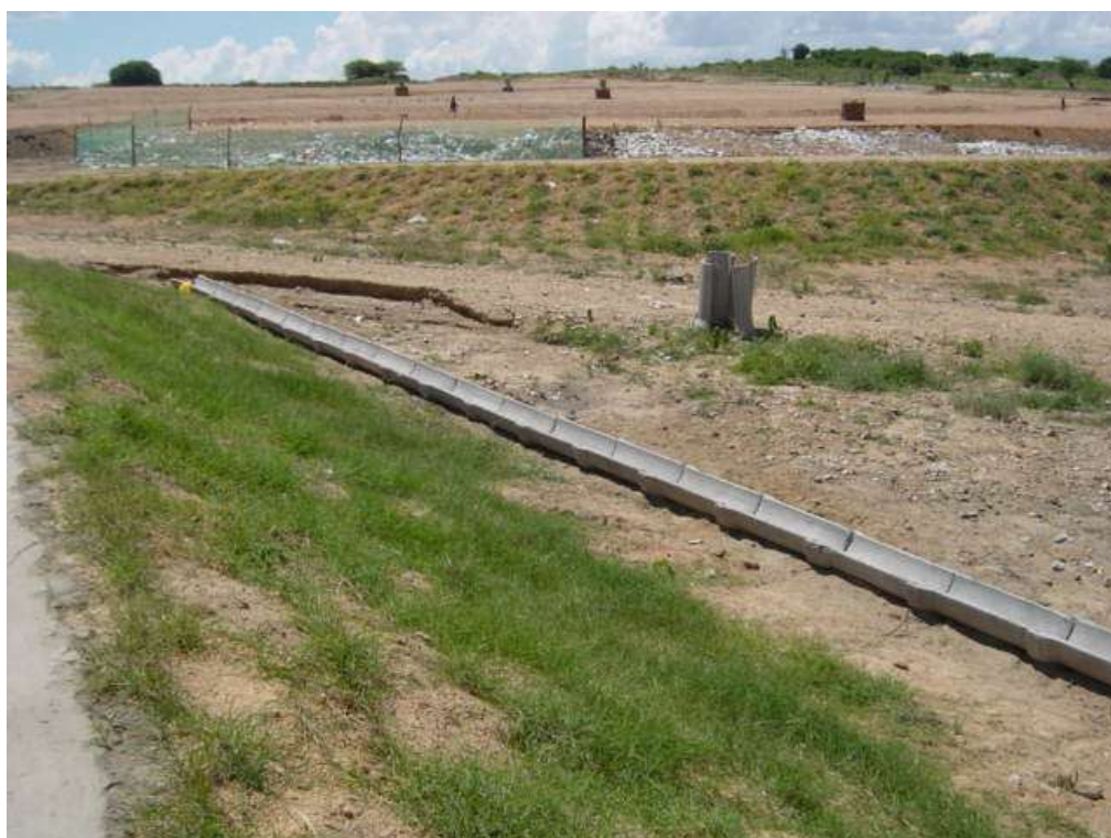
Figura 32 - Célula do aterro sanitário de Lajedo e drenos de gás (Fonte: Levantamento direto em campo - ITEP, 2011)
