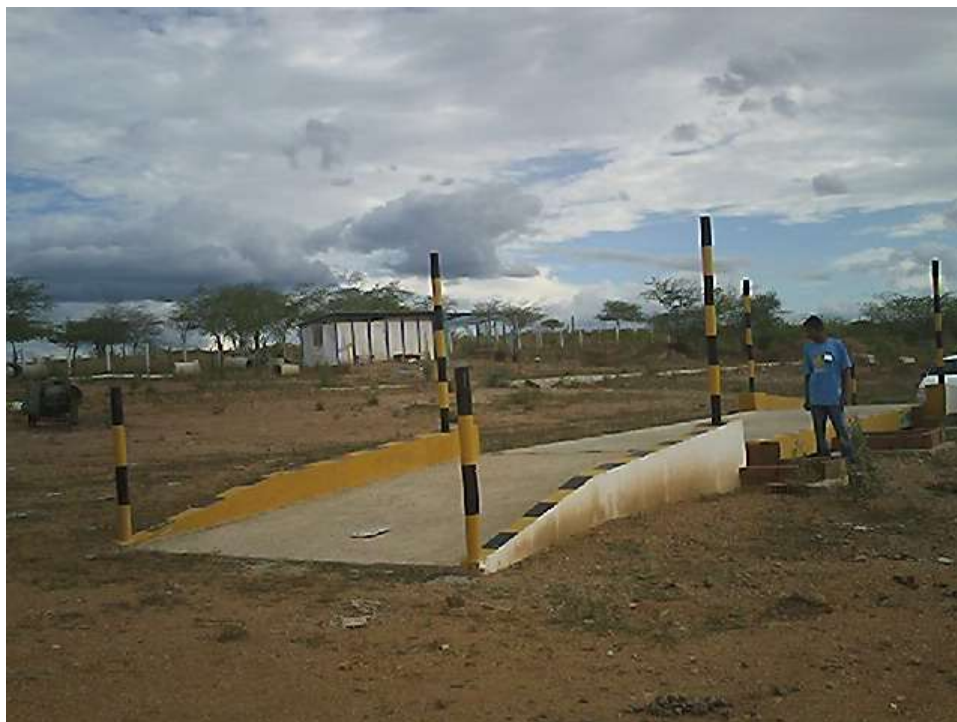
Figura 28 - Balança do aterro sanitário de Santa Cruz do Capibaribe (Fonte: Levantamento direto em campo - ITEP, 2011)
