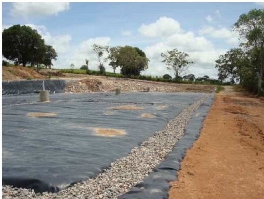
Figura 37 - Drenos de gás do aterro de Sairé no início da operação (Fonte: BSA, 2008)
