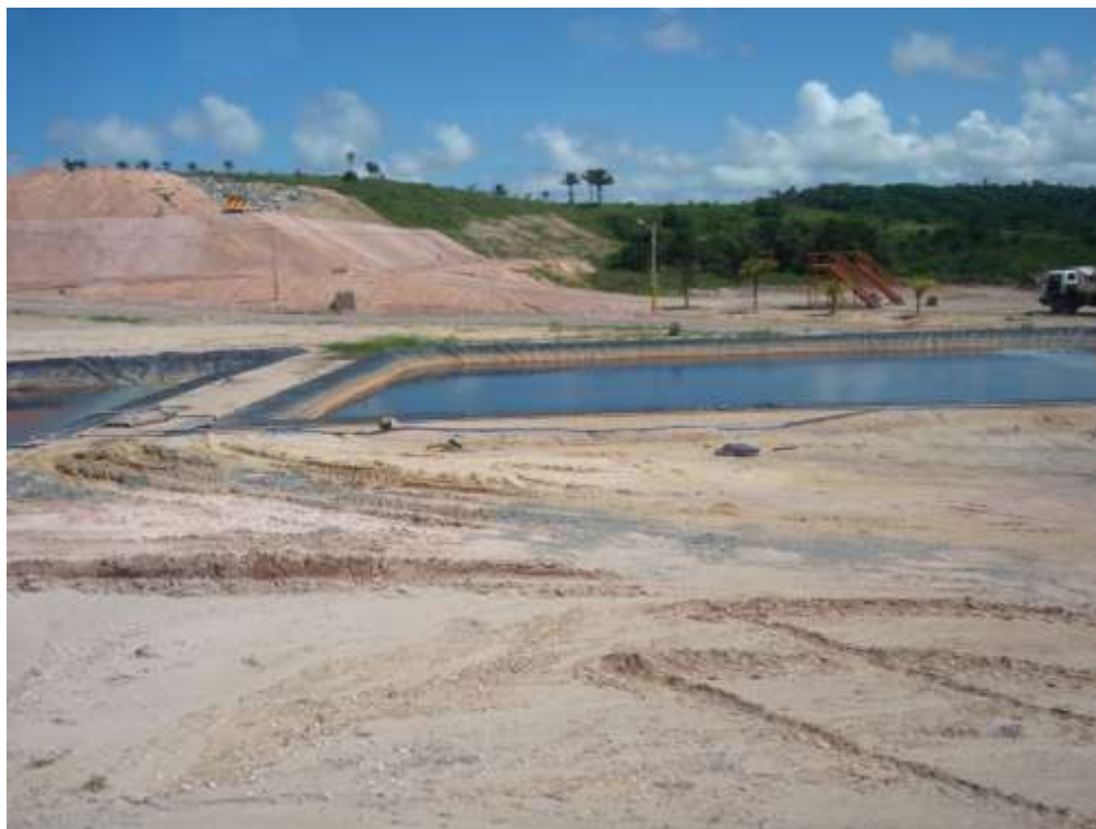
Figura 63 - Lagoa de equalização e célula do aterro de Jaboatão dos Guararapes (Fonte: Levantamento em campo - Itep, 2011)
