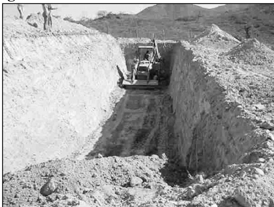
Figura 15 – Abertura de Valas – ASPP
