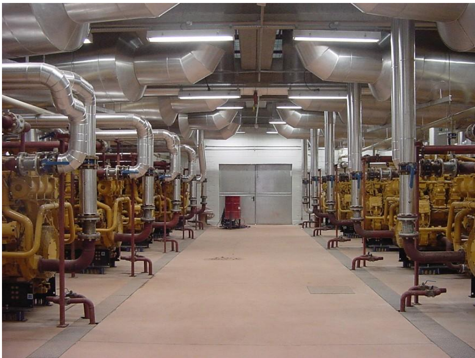
Figura 32 – Usina de Geração de energia de biogás do aterro Bandeirante Fonte: Sítio da Prefeitura Municipal de São Paulo
