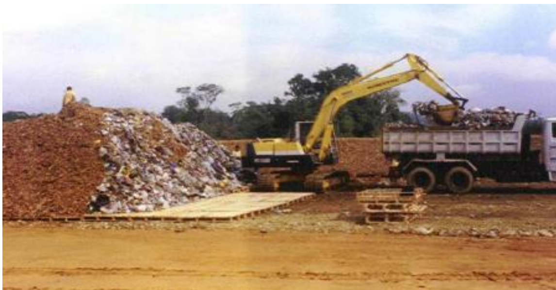
Figura 18 – Montagem de uma leira – Blumenau – Sistema Faber-Ambra
