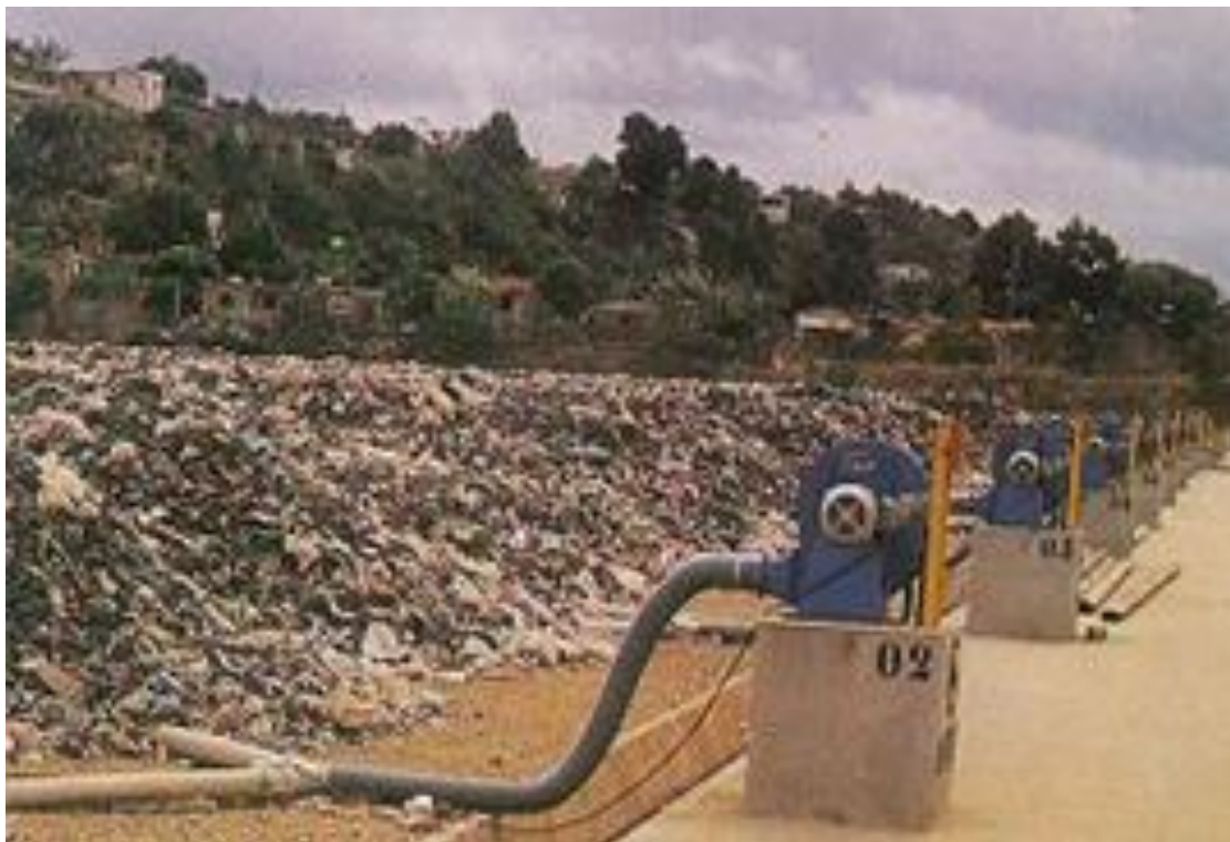
Figura 25 –Insuflação de ar na base das leiras em paralelo – Tecnologia da Aeração Forçada
