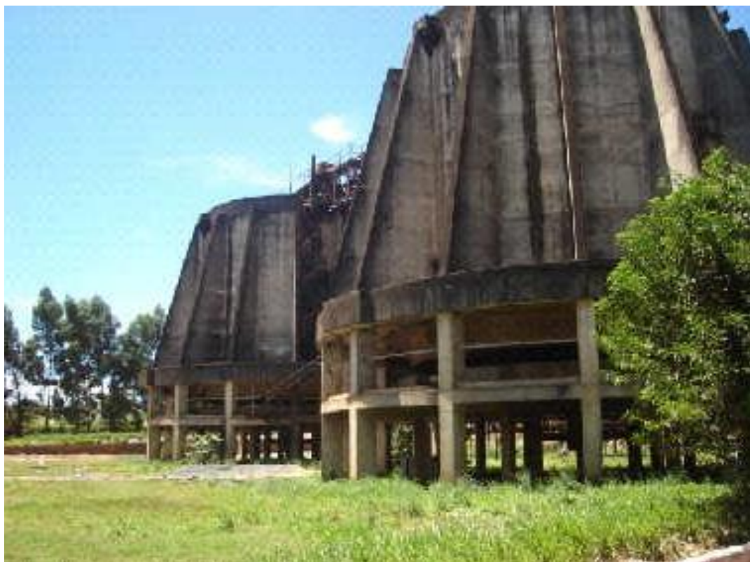
Figura 7 – Biodigestores Desativados – Tecnologia Triga Fonte: Plano Diretor de Resíduos Sólidos do Distrito Federal – 2009
