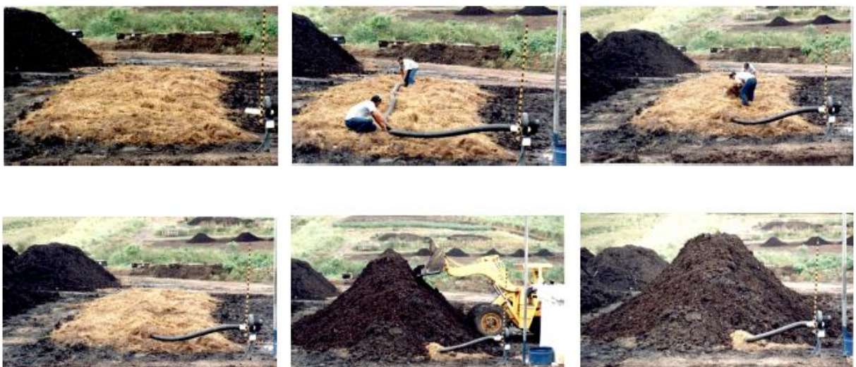
Figura 24 – Insuflação de ar na base da leira – sequência de montagem do tubo de aeração - Tecnologia da Aeração Forçada
