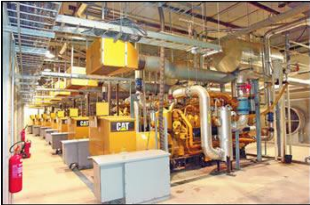
Figura 34 – Geradores na planta termelétrica de Biogás - São João Energia Ambiental
