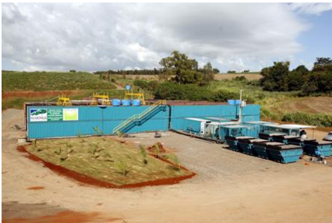
Figura 14 – Unidade de tratamento do lixo– Maringá – Sistema Biopuster
