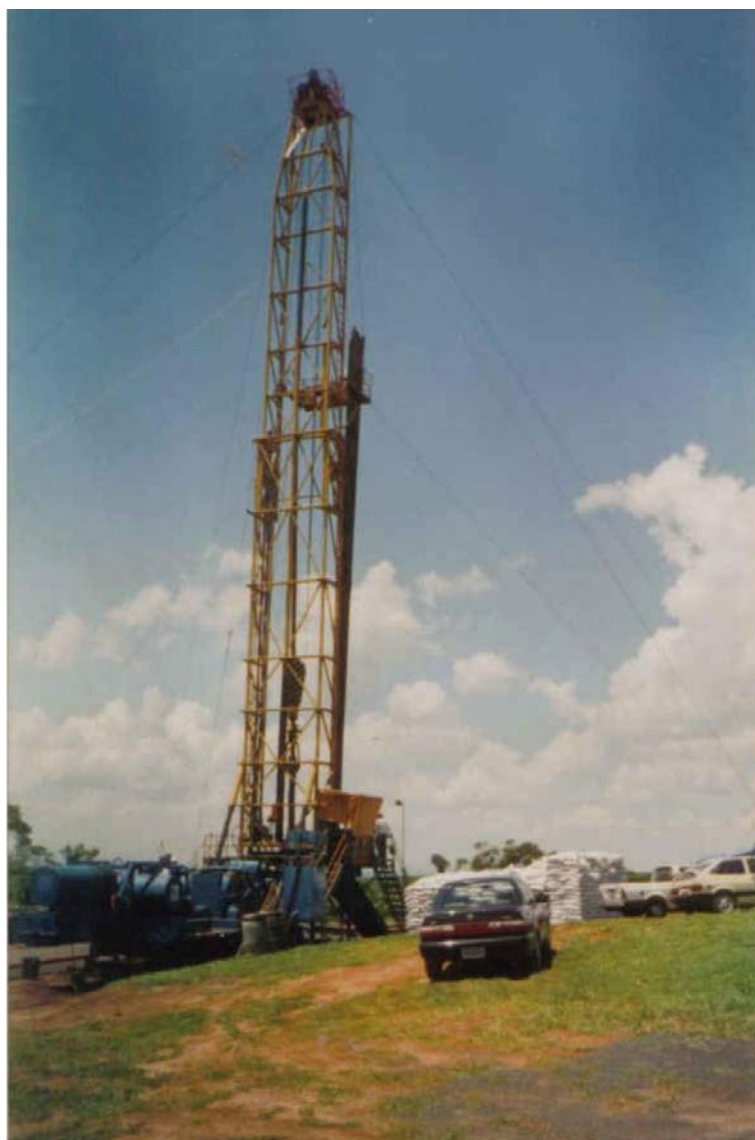
Figura 6.- Equipamento de perfuração rotativo.
