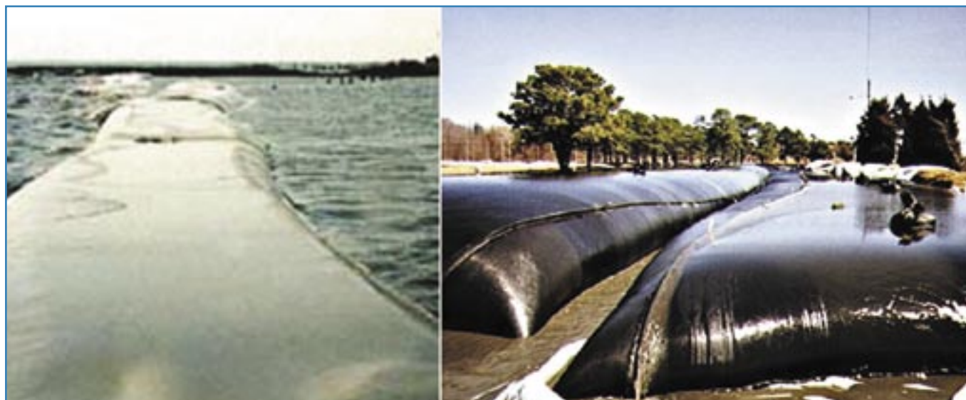
Foto 5 - Espigões construídos com tecido geotextil (geotubes)
