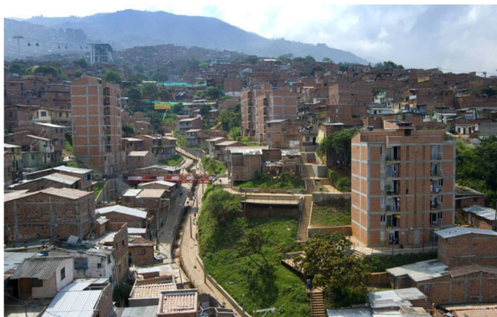
Figura 18. Vista panorámica de la intervención en la quebrada Juan Bobo. Fuente: EDU, 2007.
