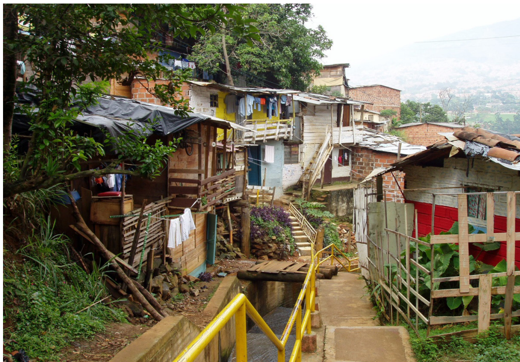
Figura 17. Situación antes de la intervención en la quebrada Juan Bobo. Fuente: EDU, 2004.
