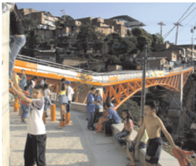
Figura 16. Ponte de Andalucía - La Francia.
