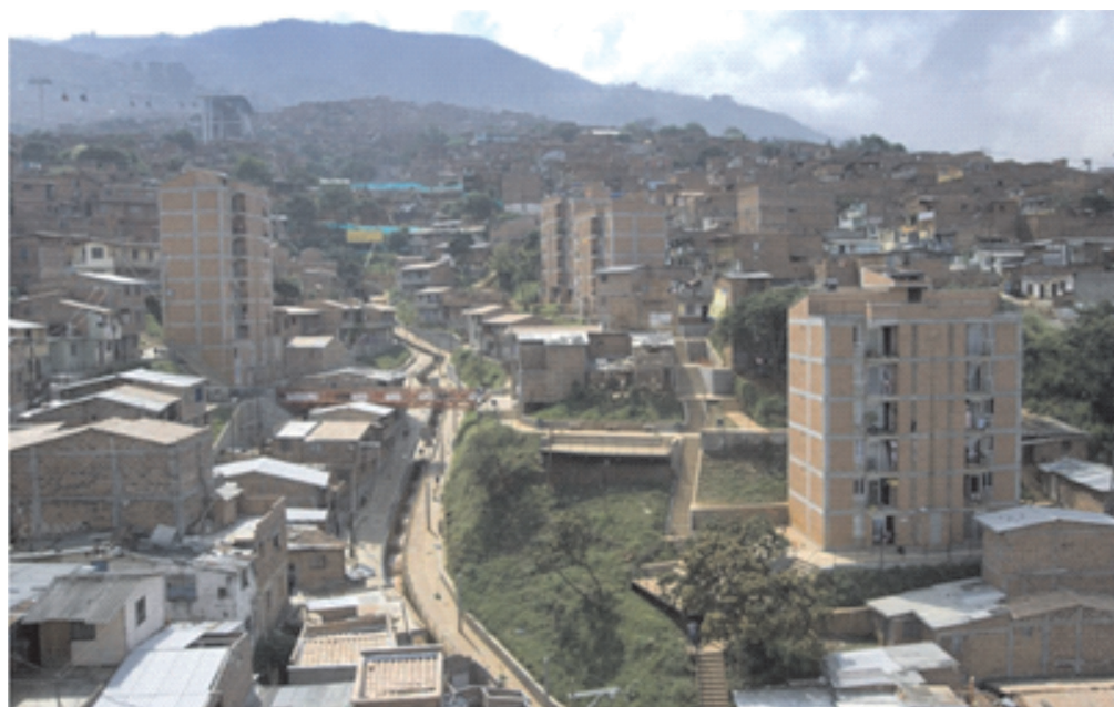
Figura 18. Vista panorâmica da intervenção na Quebrada Juan Bobo. Fonte: EDU, 2007.
