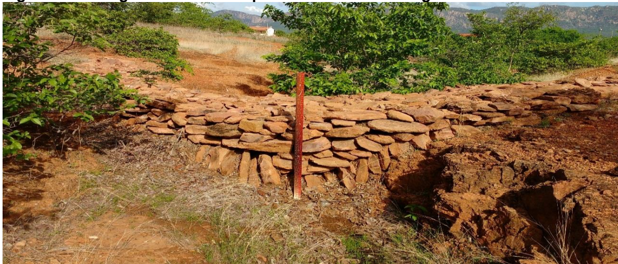
Figura. 1 - Barragem sucessiva de pedra construída em Jaguaribe-CE.
