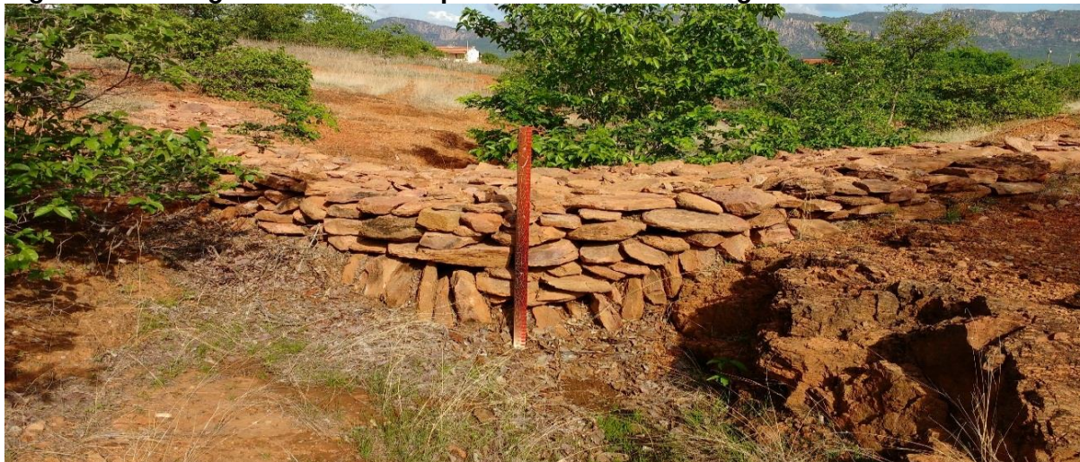
Figura. 1 - Barragem sucessiva de pedra construída em Jaguaribe-CE.
