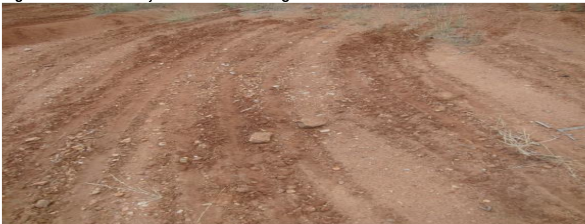
Figura. 4 – Escarificação realizada em Jaguaribe-CE.
