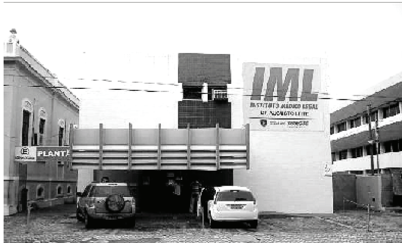
Foto 5 – Prédio do IML/SE
