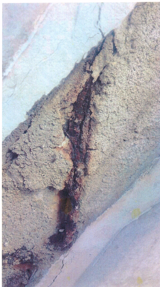
Figura 2: Detalhe de armadura em avançado estágio de corrosão.
