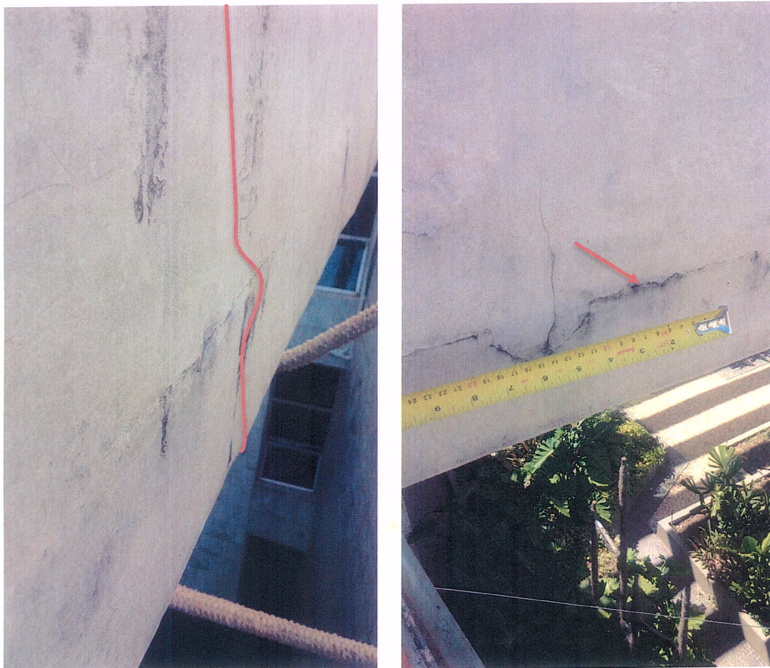
Figuras 3 e 4: Lateral da viga com deformação e trinca longitudinal indicando a expansão da armadura por efeitos corrosivos.
