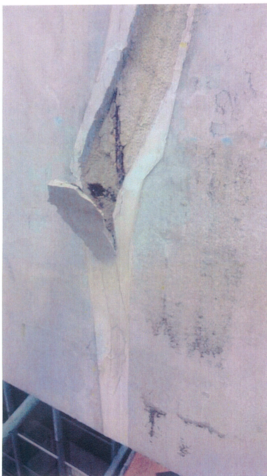
Figura 1: Desprendimento do mastique de vedação e armadura em avançado estágio de corrosão.
