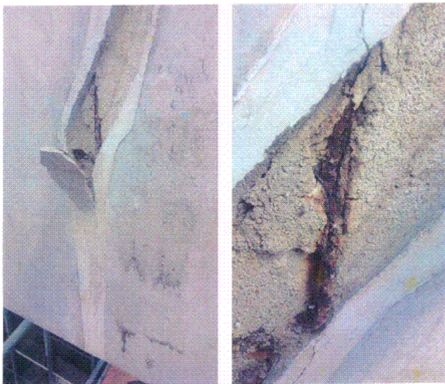
Figura 3 - Desprendimento do mastique de vedação e armadura em avançado estágio de corrosão
