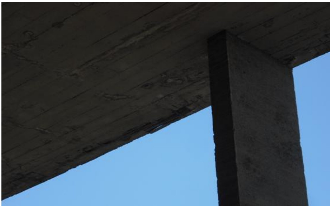
Figura 7 - Desprendimento de concreto da face inferior da laje, ferragem em processo de corrosão - Palácio da Justiça Raymundo Faoro
