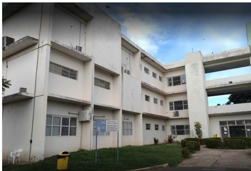
Figura 2 - Infraestrutura predial da SETEC – UFMT.
