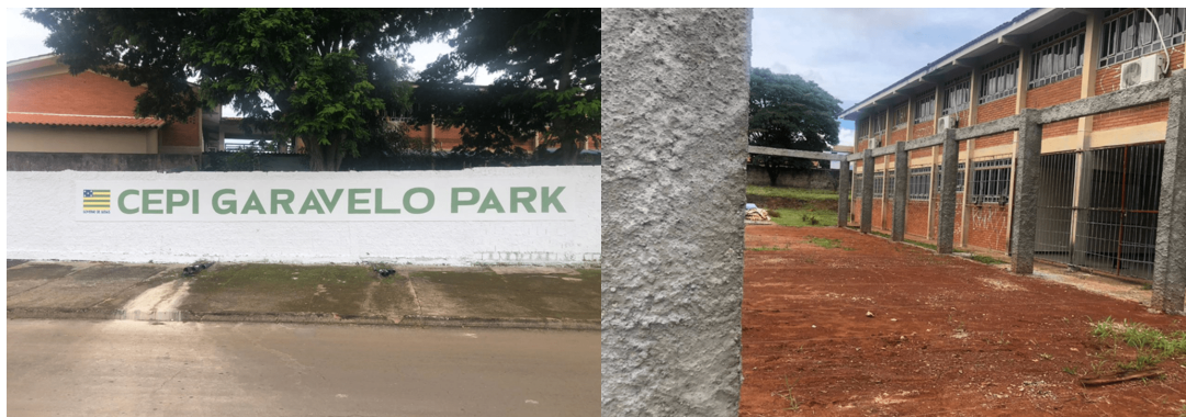
Figura 31 – Foto da fachada e de parte das obras - CEPI GARAVELLO PARK - Aparecida de Goiânia/GO
