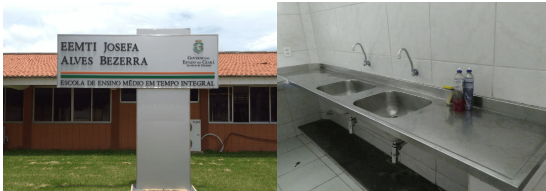
Figura 33 – Foto da fachada e de parte das obras - EEMTI JOSEFA ALVES BEZERRA - Jucás/CE
