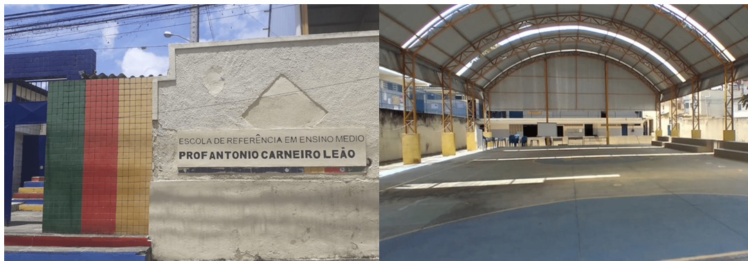
Figura 34 – Foto da fachada e de parte das obras - EREM PROF ANTONIO CARNEIRO LEÃO - Camaragibe/PE
