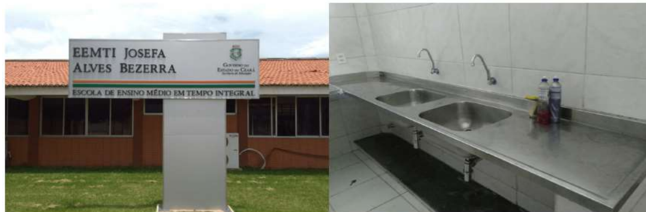
Figura 33 – Foto da fachada e de parte das obras - EEMTI JOSEFA ALVES BEZERRA - Jucás/CE
