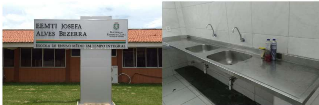
Figura 33 – Foto da fachada e de parte das obras - EEMTI JOSEFA ALVES BEZERRA - Jucás/CE
