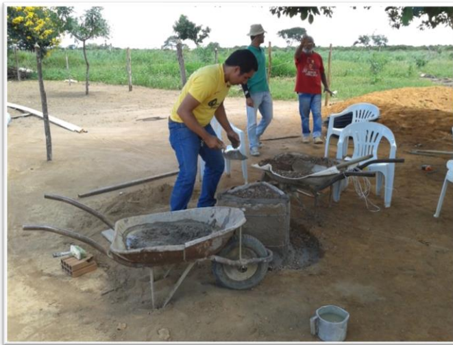
Figura 15: Montagem/construção da base de sustentação da caixa d'água
