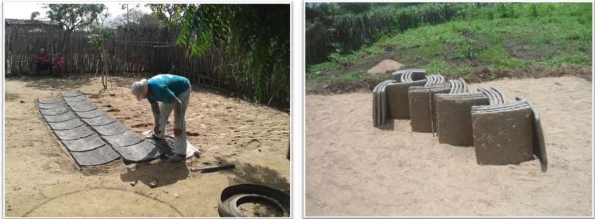
Figura 3: Confeção das placas de cimento do filtro biológico
