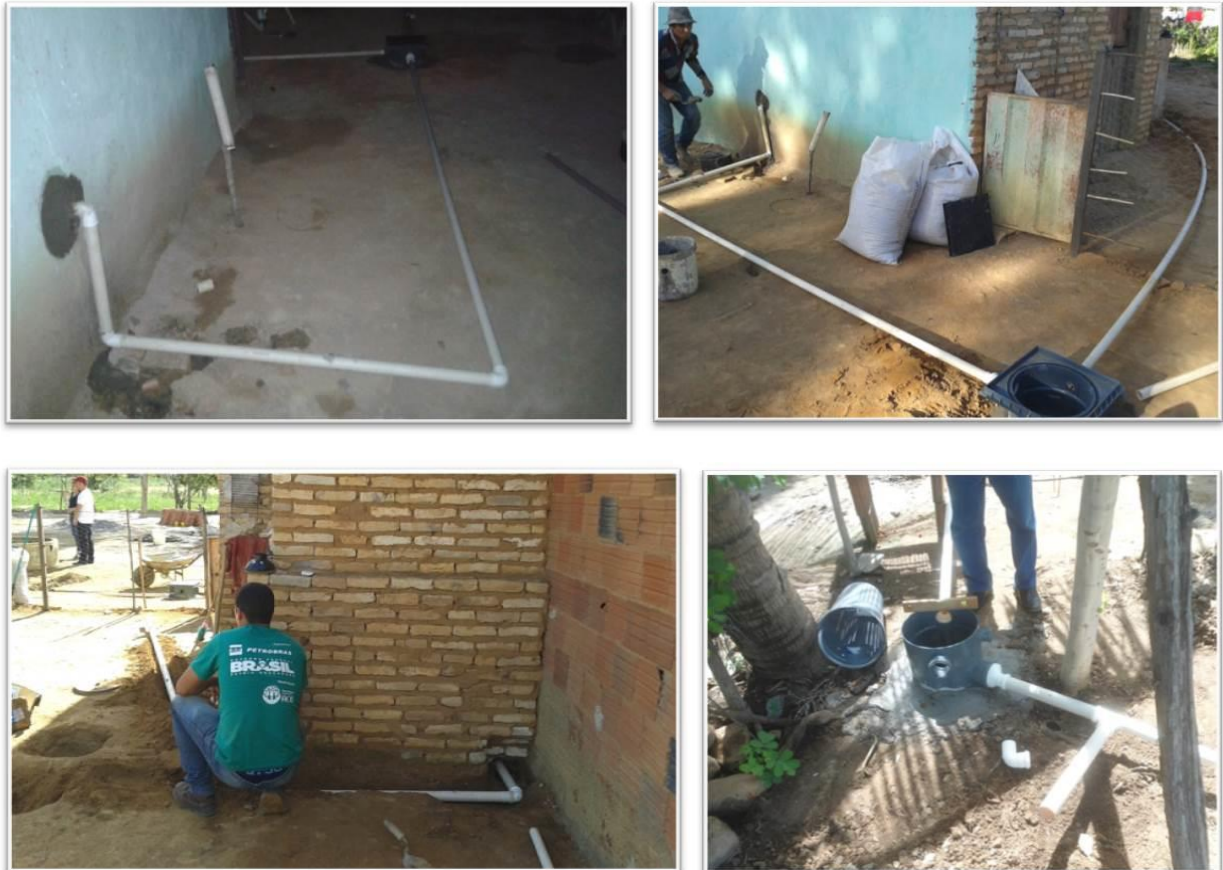
Figura 9: Instalação do sistema hidráulico
