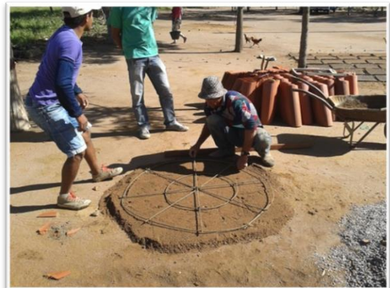
Figura 8: Montagem/construção da tampa do tanque de reuso
