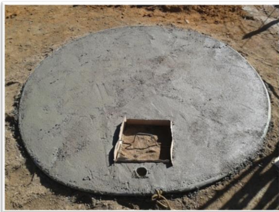
Figura 8: Montagem/construção da tampa do tanque de reuso
