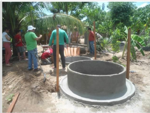
Figura 14: Montagem/construção da cobertura do filtro e do minhocário
