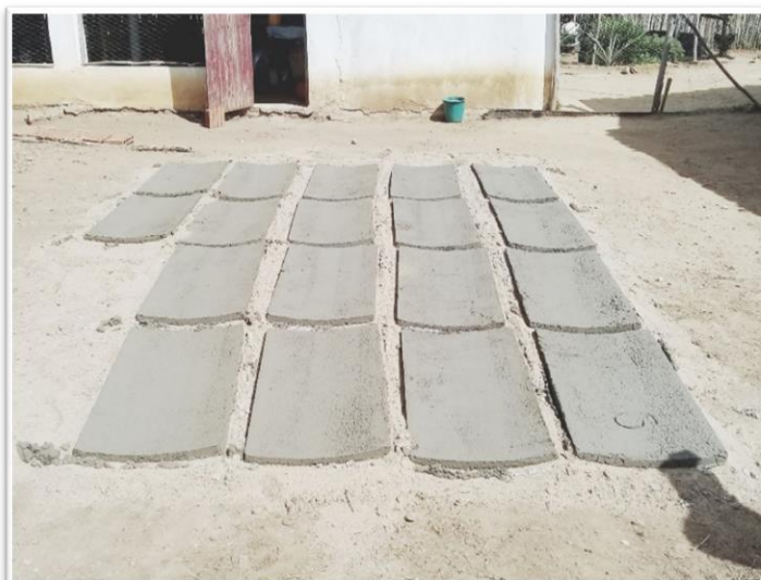
Figura 17: Modelo das placas de cimento da fossa ecológica
