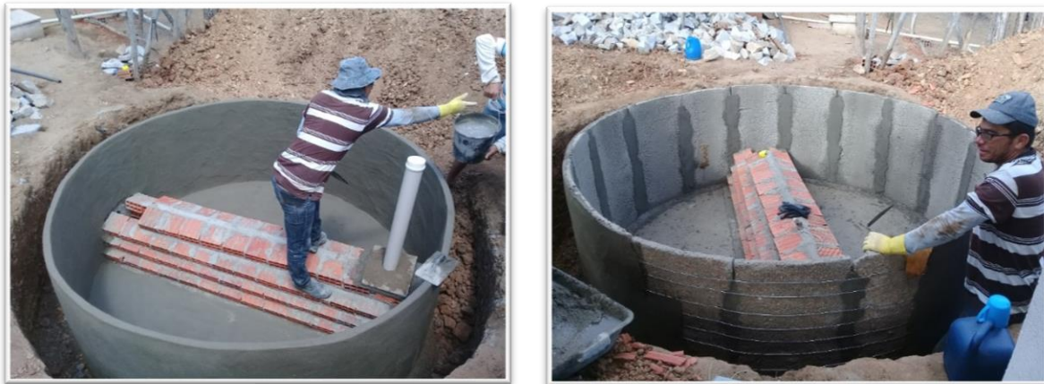
Figura 19: Reboco interno, externo e contrapiso
