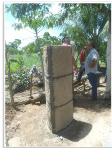
Figura 15: Montagem/construção da base de sustentação da caixa d'água
