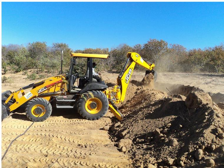
O operador deve observar atentamente o balizamento para que o buraco tenha no mínimo 8,00 m de diâmetro, tendo o cuidado de não aprofundar além dos 1,8 previstos. Escavar mais que o especificado além de desnecessário é prejudicial, pois o aterramento corretivo mal compactado pode comprometer a estabilidade do piso (fundo) da cisterna.
