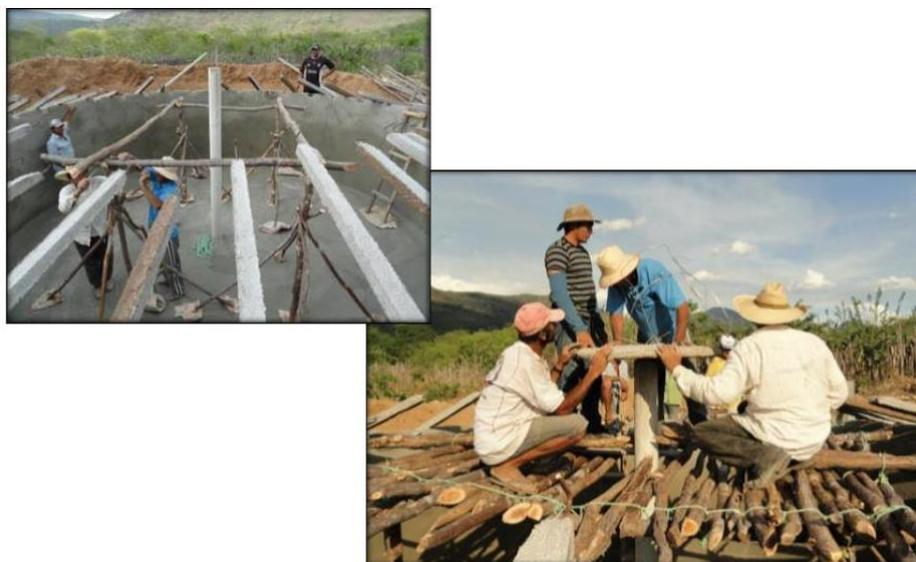
Os ganchos das vigas devem ser amarrados com arame galvanizado nº 12. Em seguida, deve ser feita uma amarração na parede na altura das vigas com 20 voltas de arame.
