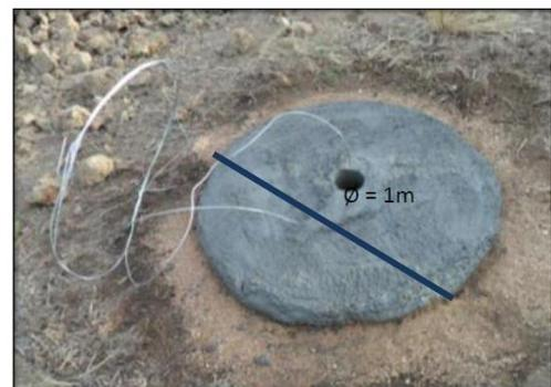
Primeiramente faz-se o lançamento de concreto até a altura de 0,04 m (4 cm). Em seguida, coloca-se a armadura de aço, e sobre ela, lançar mais 0,04 m (4 cm) de concreto. A armadura deve ser de aço CA 50 1/4 com os elementos dispostos em cruz.
