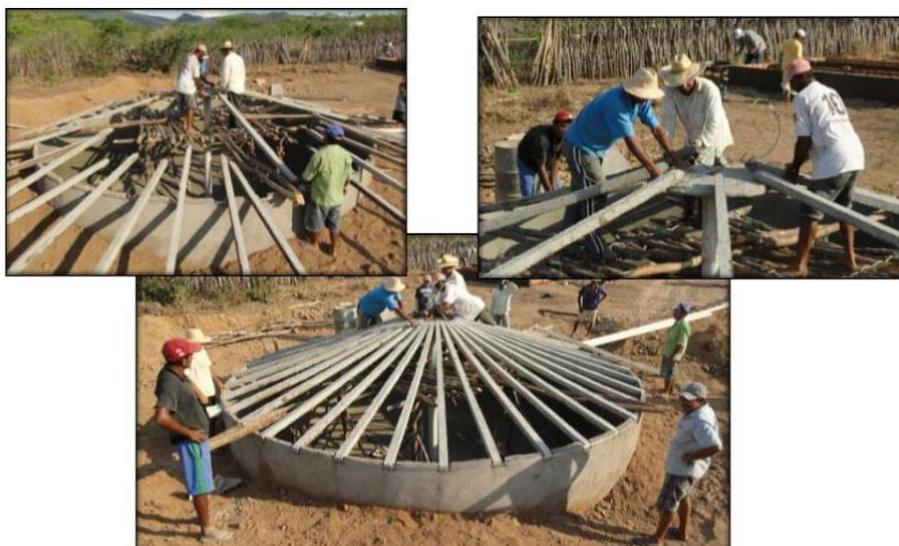
Sobre a bandeja e os caibros devidamente amarrados deve ser lançado concreto suficiente para cobri-los, formando um capuz.
