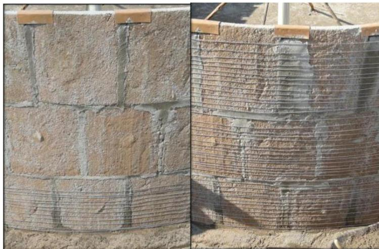
O reboco interno deve ser ligado ao piso da cisterna com o rodapé arredondado para evitar vazamento.
