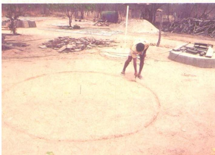
Uma maneira prática para marcar as bordas da escavação é prender uma das pontas de um cordão rígido em uma estaca cravada no local onde será o centro do buraco. Em seguida,
