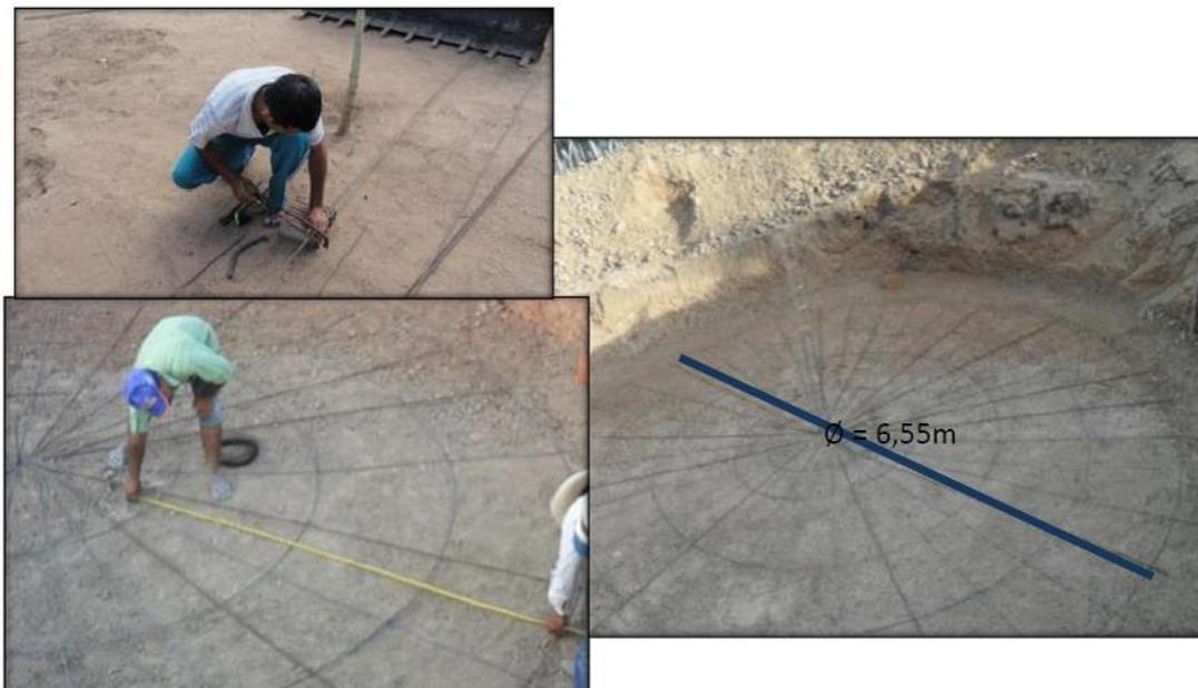
A armadura deve ser construída com Aço C 50 ¼ (6,3 mm), com 5 arcos concêntricos e 16 barras de ferro de 3,20 m cada, dispostos em raios.
