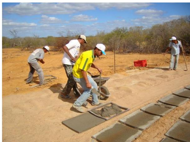
Ao invés de fazer o corte nas placas com o concreto ainda mole, é mais prático preencher o espaço de 10 x 10 cm no canto indicado do molde, parafusando um quadrado de madeira com as dimensões indicadas, de modo a obter as placas diferenciadas. (Figura 5).
