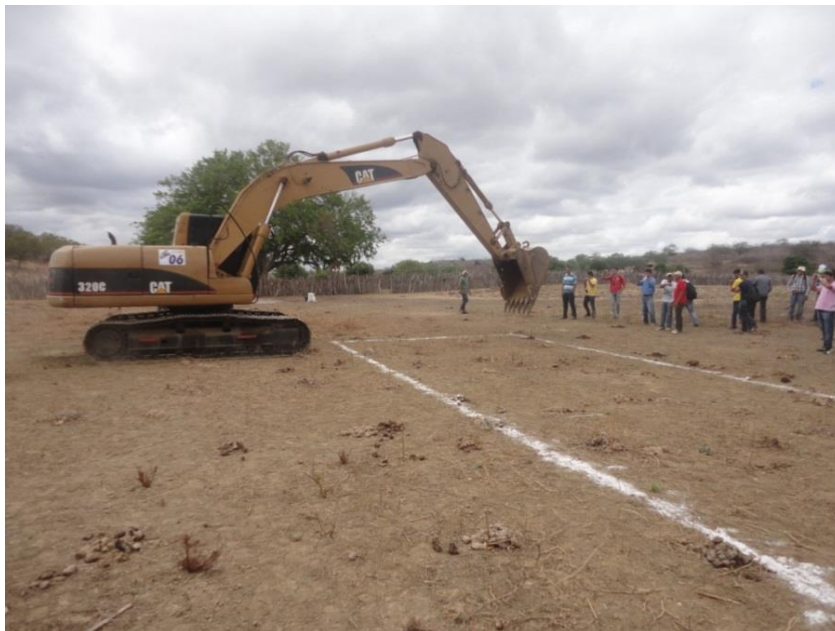
Figura 2: Marcação do terreno
