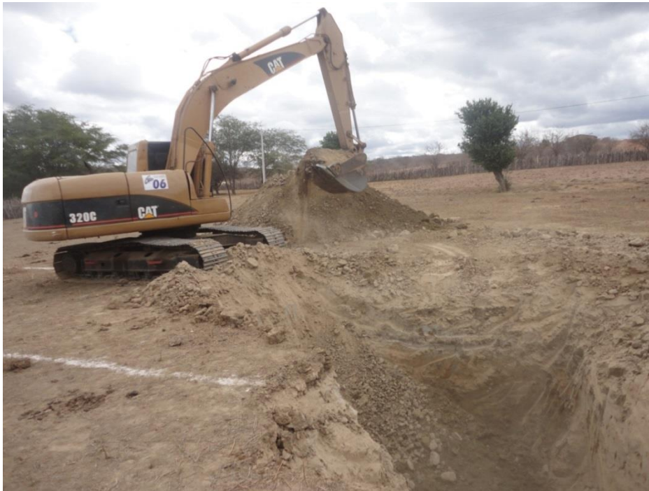
Figura 3: Escavação do buraco
