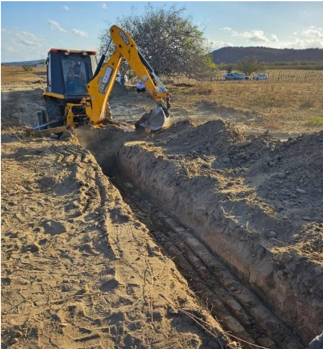
Figura 5: Escavação da vala mecanizada
