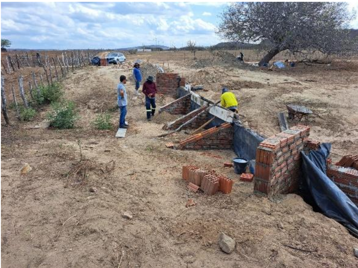
Figura 9: Construção do vertedouro
