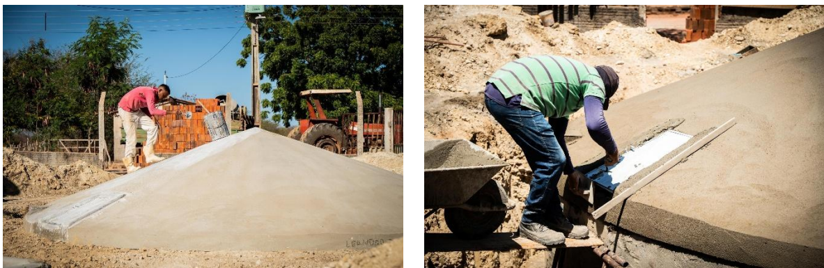
Figura 17: Reboco das placas da cobertura do reservatório
