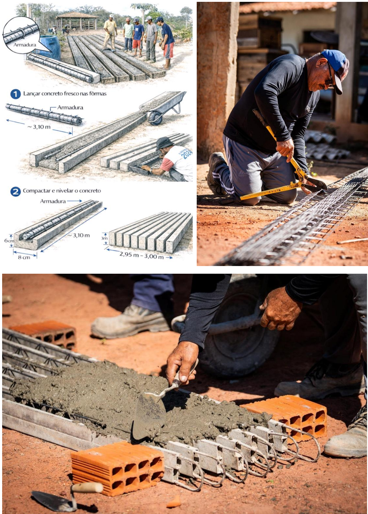
Figura 13: Confeção dos caibros da cobertura da cisterna
