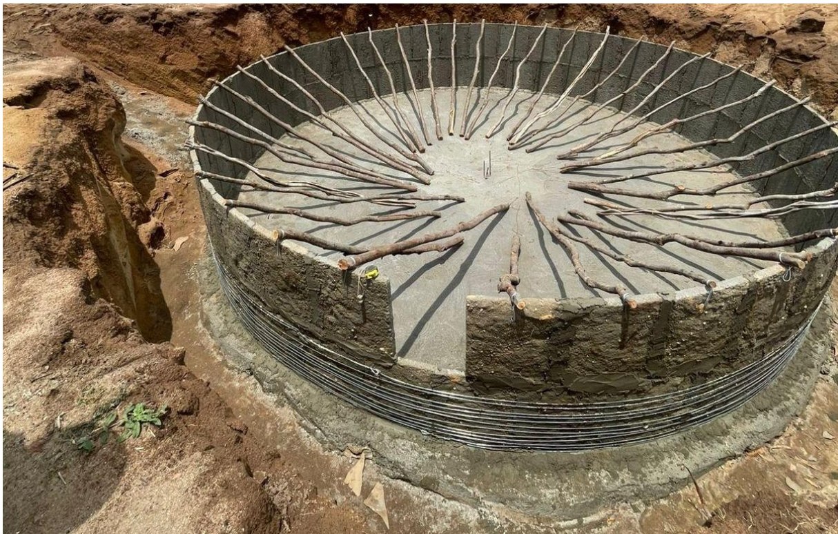
Figura 9: Montagem das placas da parede da cisterna
