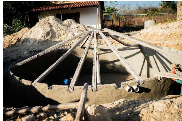
Figura 14: Colocação da coroa e dos caibros da cobertura da cisterna
