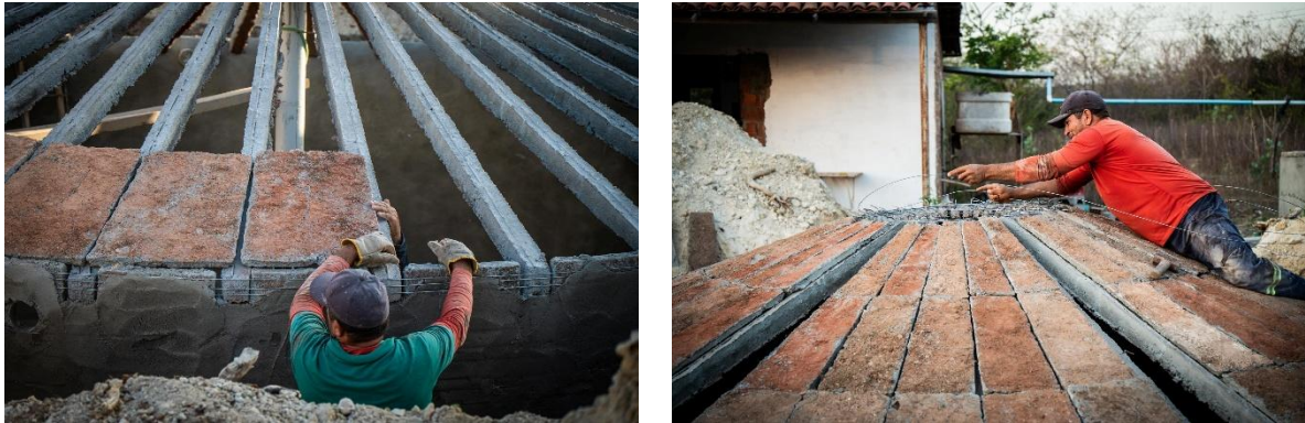
Figura 16: Amarração das placas e dos caibros
