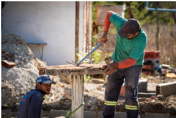
Figura 14: Colocação da coroa e dos caibros da cobertura da cisterna
