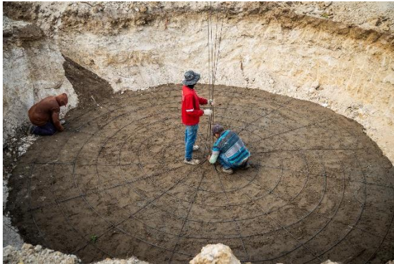
Figura 11: Construção do pilar central do reservatório
