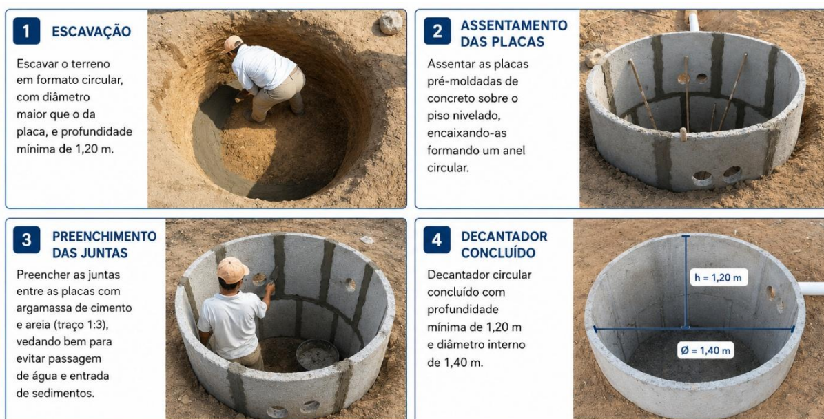
Figura 18: Construção dos decantadores em formato circular (com placas pré-moldadas)
