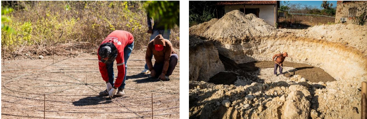
Figura 5: Construção da laje do fundo da cisterna
