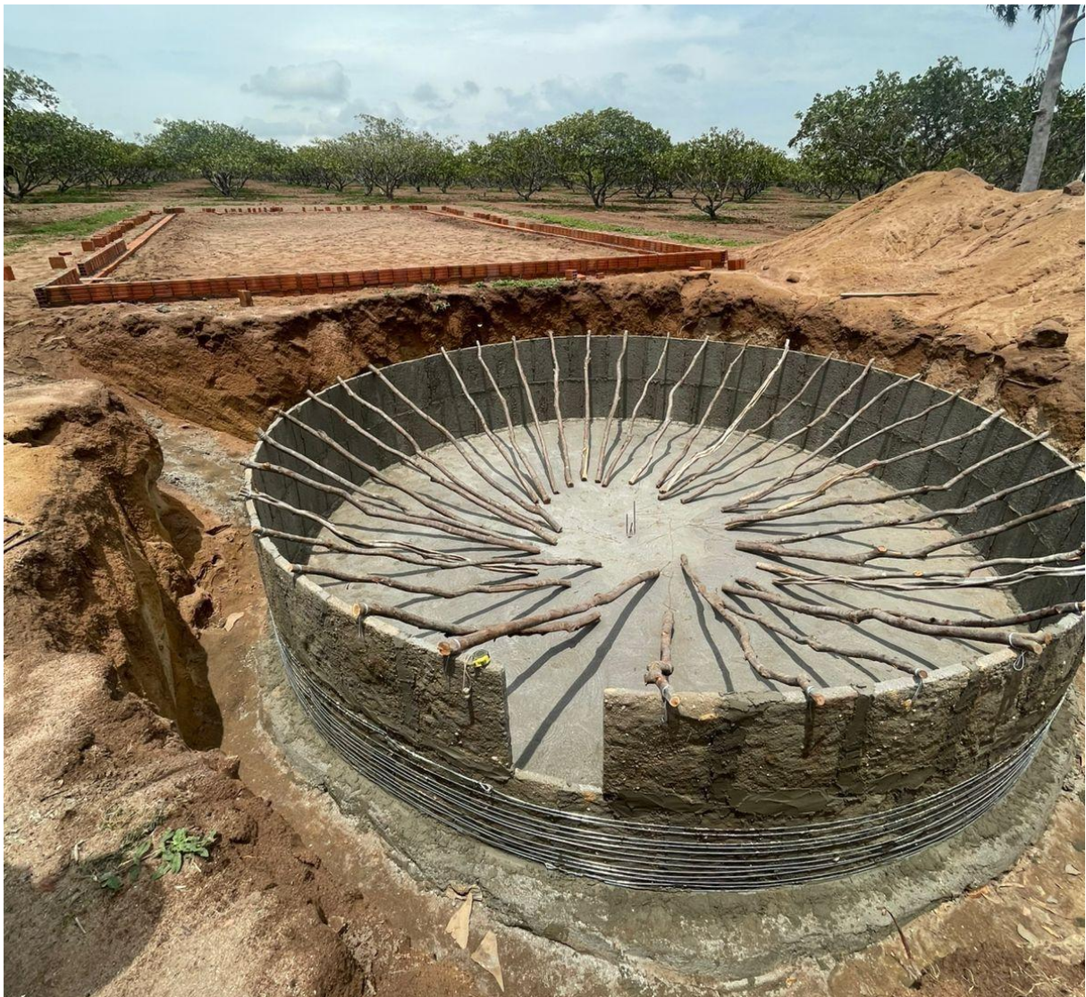
Figura 9: Montagem das placas da parede da cisterna
