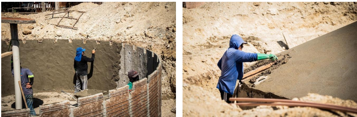
Figura 10: Acabamento da cisterna (amarração, reboco externo e interno)
