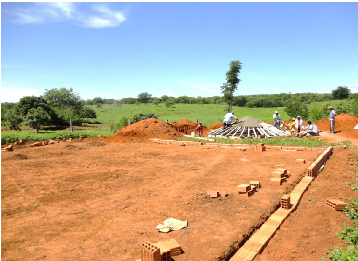
Figura 18: Construção do sistema de captação (calçadão)
