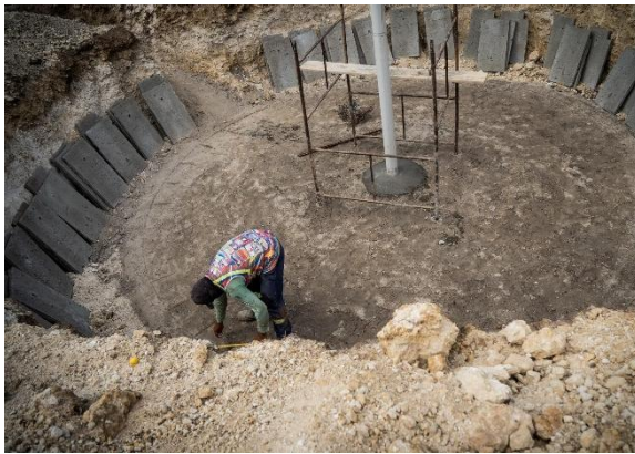
Figura 8: Montagem das placas da parede da cisterna
