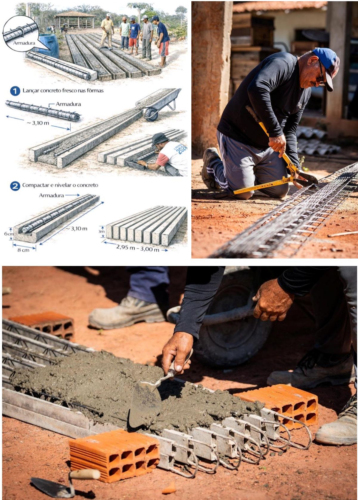
Figura 13: Confeção dos caibros da cobertura da cisterna
