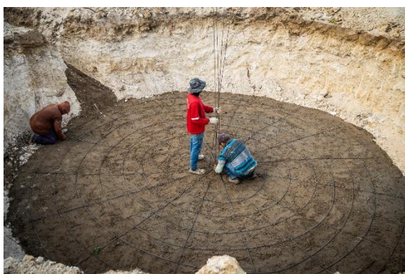
Figura 11: Construção do pilar central do reservatório
