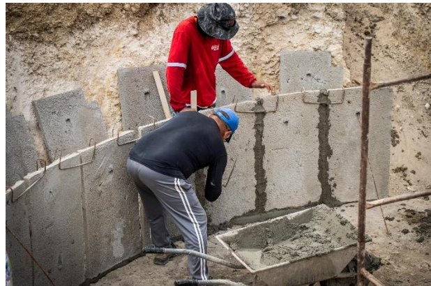
Figura 8: Montagem das placas da parede da cisterna
