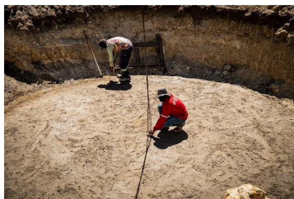
Figura 11: Construção do pilar central do reservatório
