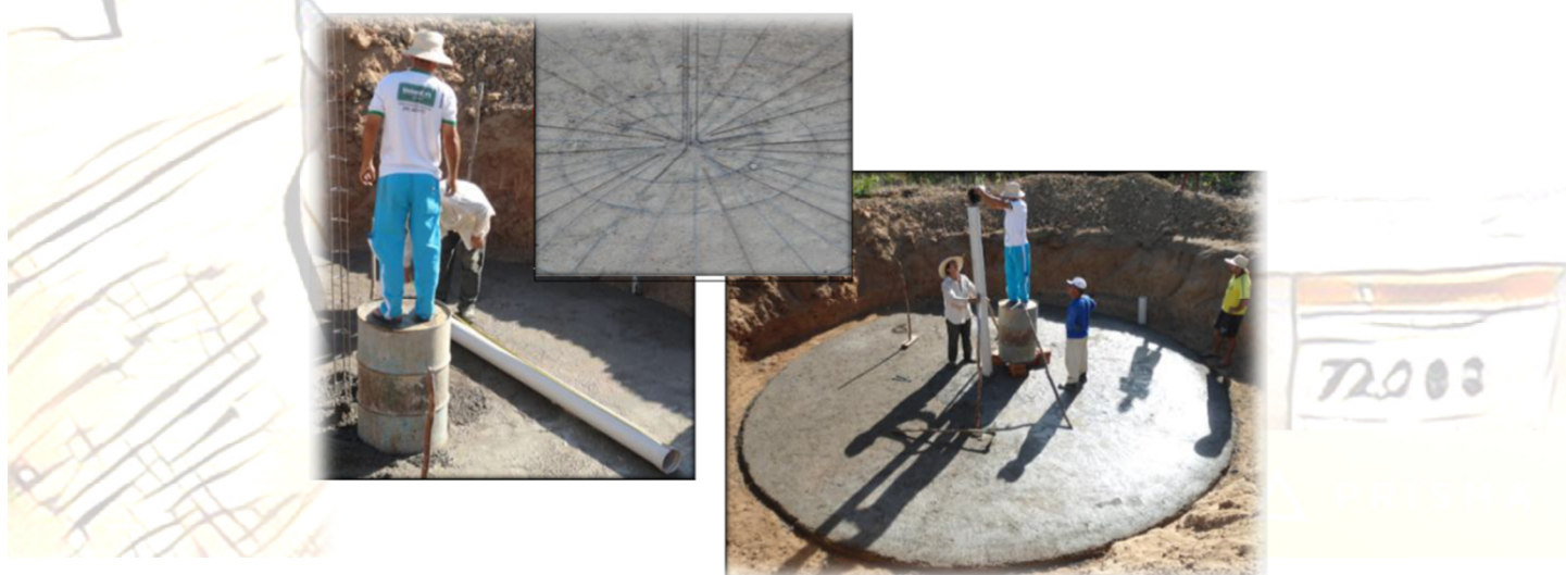
Figura 10 – Construção da coluna Central
