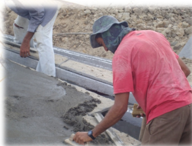
Figura 14 - Colocação das placas de cobertura
