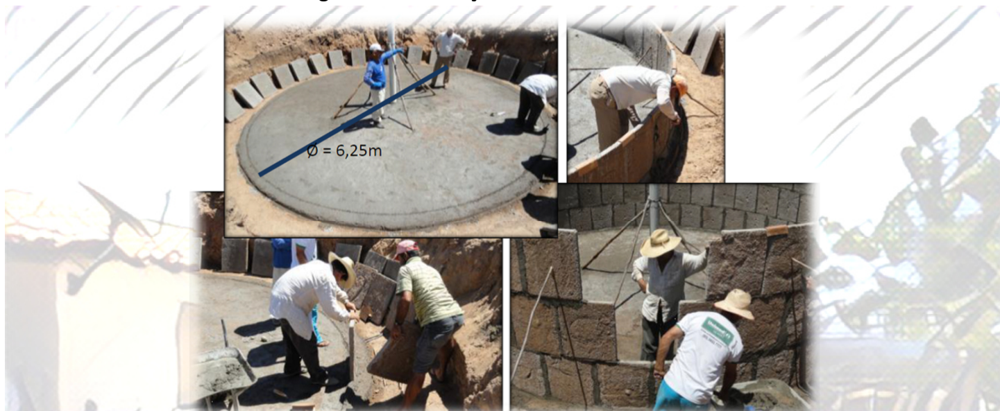
Figura 9 – Construção da Parede da cisterna
