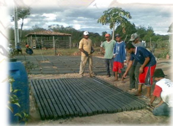
Figura 7 – Confeção dos caibros da cobertura da cisterna
