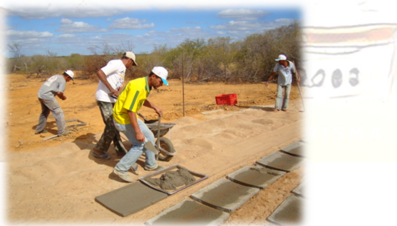
Figuras 3 e 4 – Dimensões e confecção das placas da parede da cisterna
