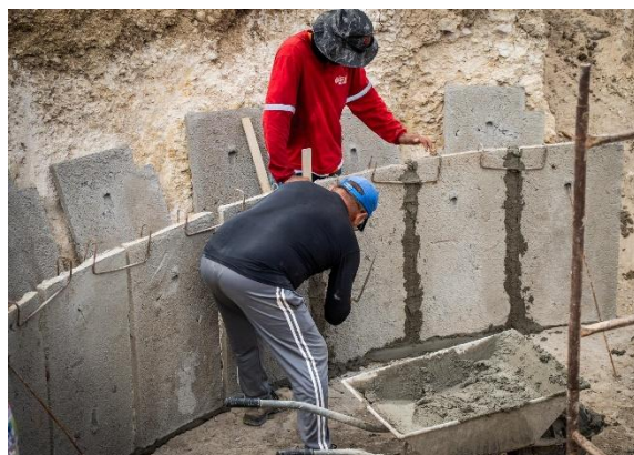
Figura 6: Montagem das placas da parede da cisterna
