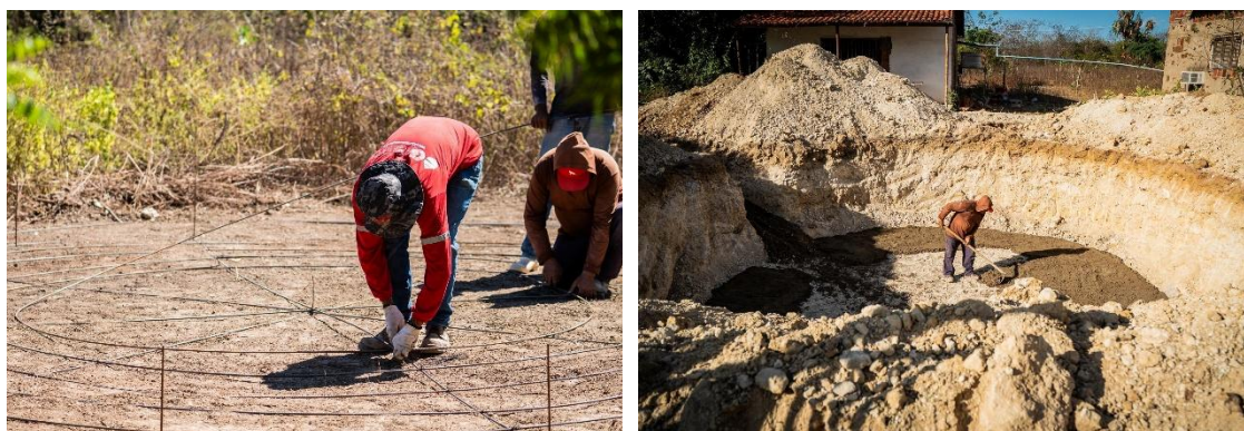
Figura 3: Armadura de ferro da laje do fundo da cisterna
