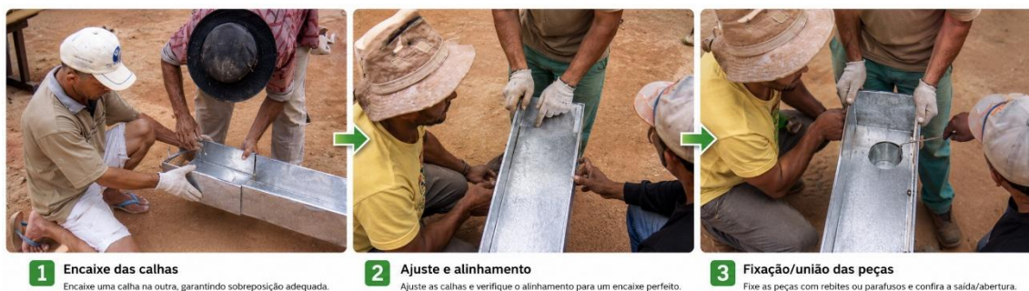
Figura 17: Fixação das calhas de bica
