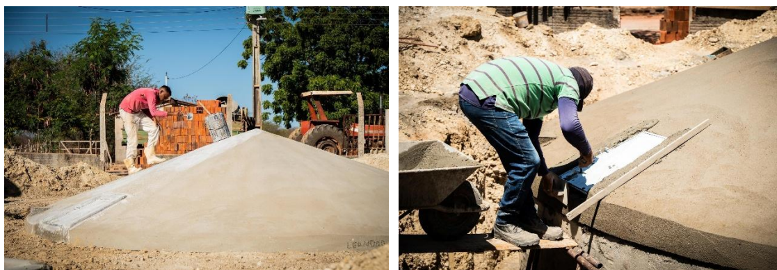
Figura 15: Reboco das placas da cobertura do reservatório
