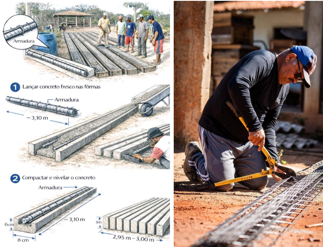
Figura 11: Confeção dos caibros da cobertura da cisterna
