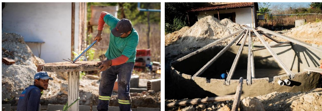
Figura 12: Colocação da coroa e dos caibros da cobertura da cisterna
