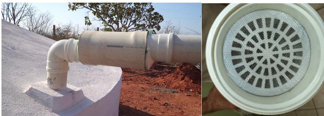
Figura 16: Filtro coador no modelo de PVC e suas reduções
