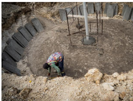
Figura 6: Montagem das placas da parede da cisterna
