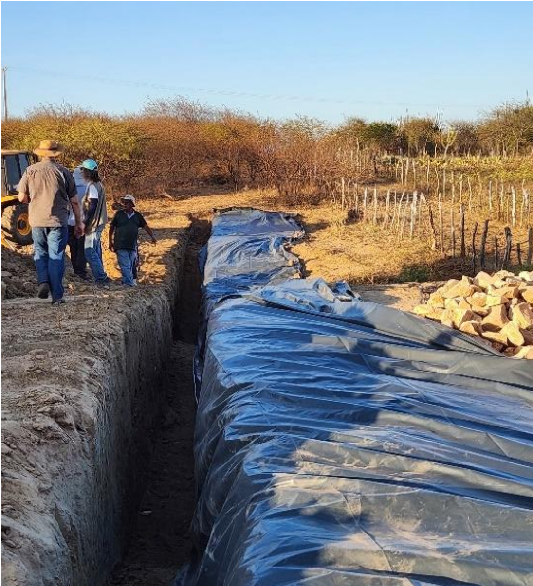
Figura 7: Instalação da lona impermeável
