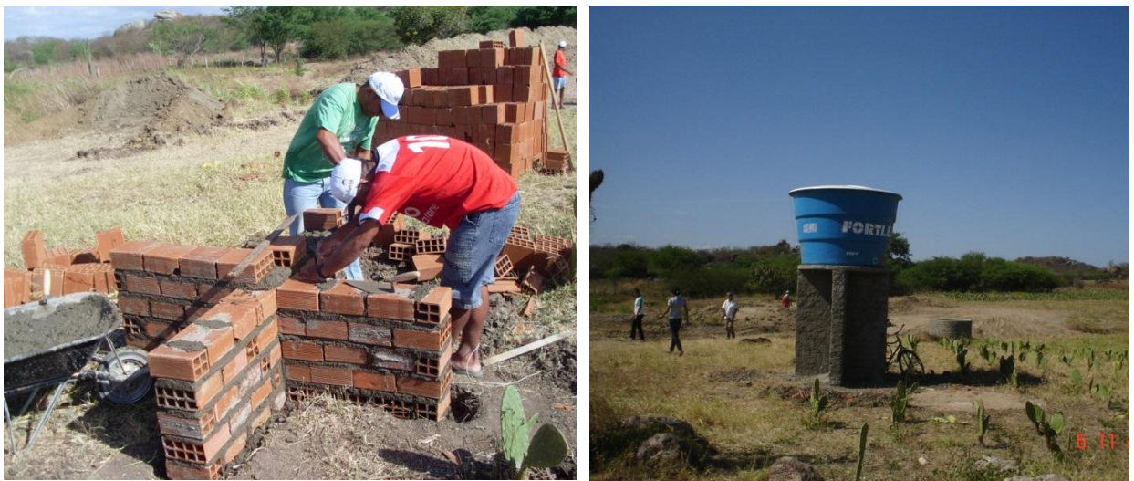
Figura 11: Instalação da caixa d'água
