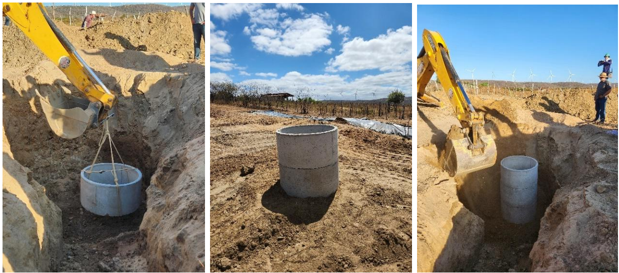
Figura 10: Construção do poço (cacimbão)
