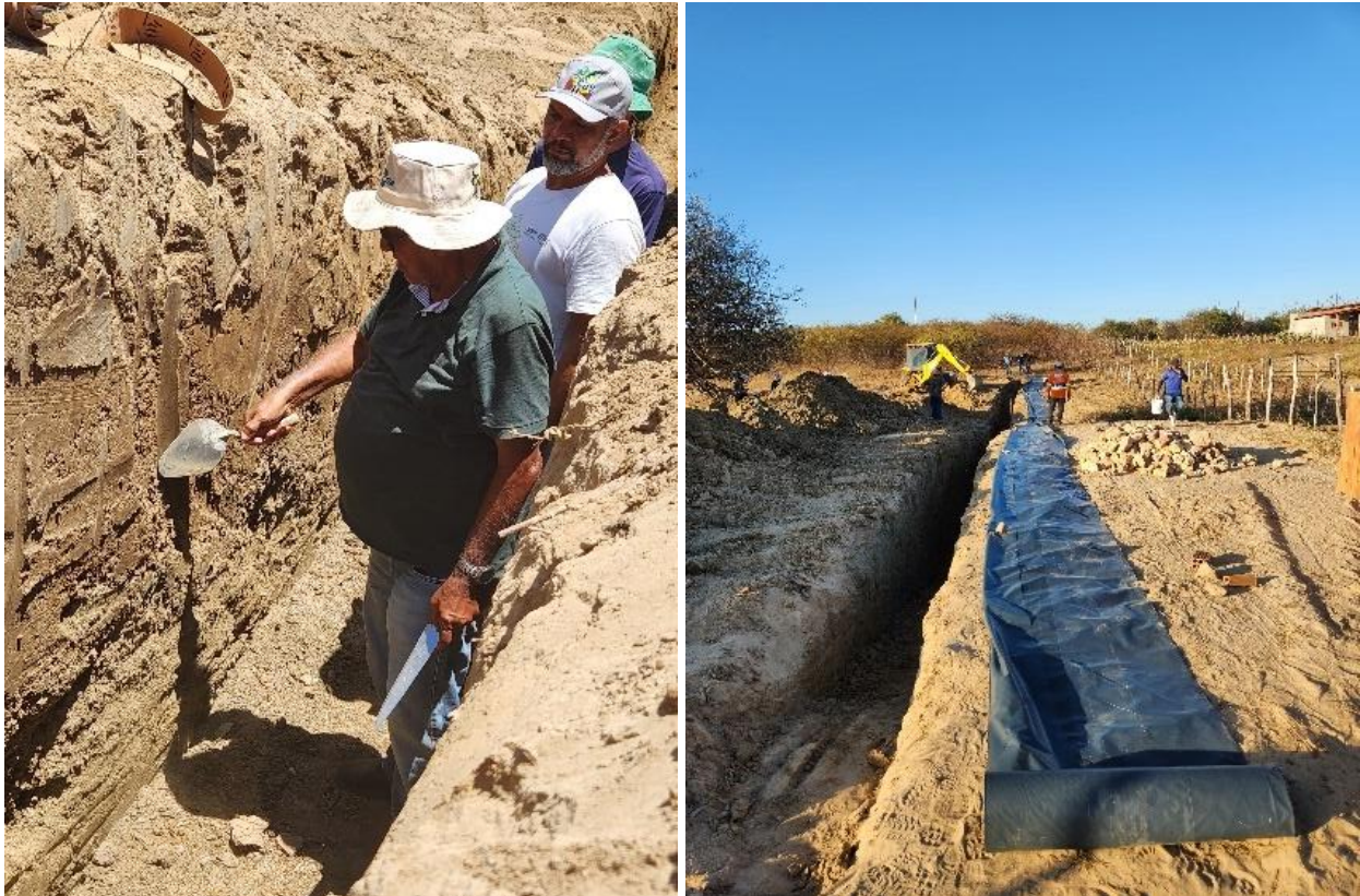
Figura 6: Acabamento da escavação e preparo para colocação da lona
