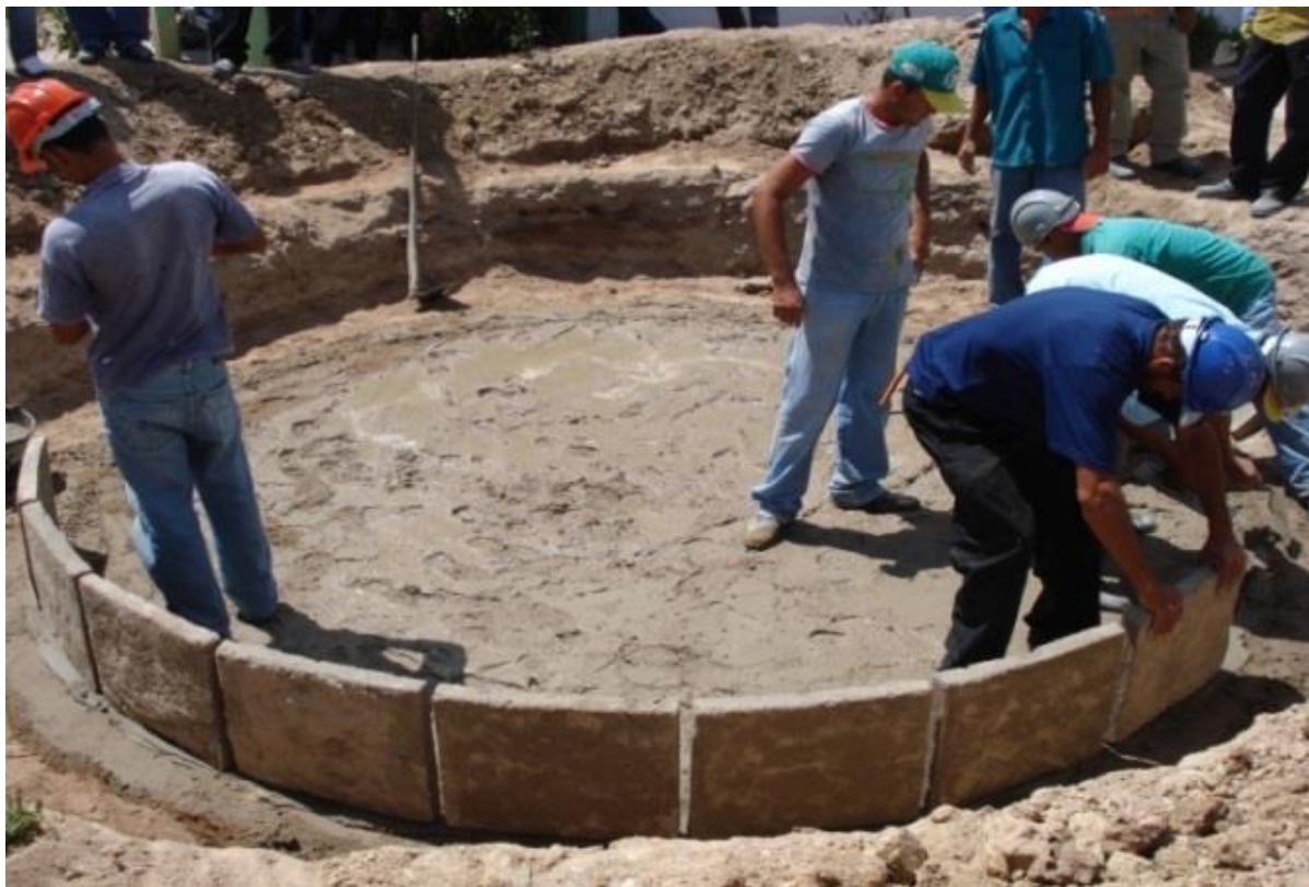
Figura 7: Levantamento da parede
