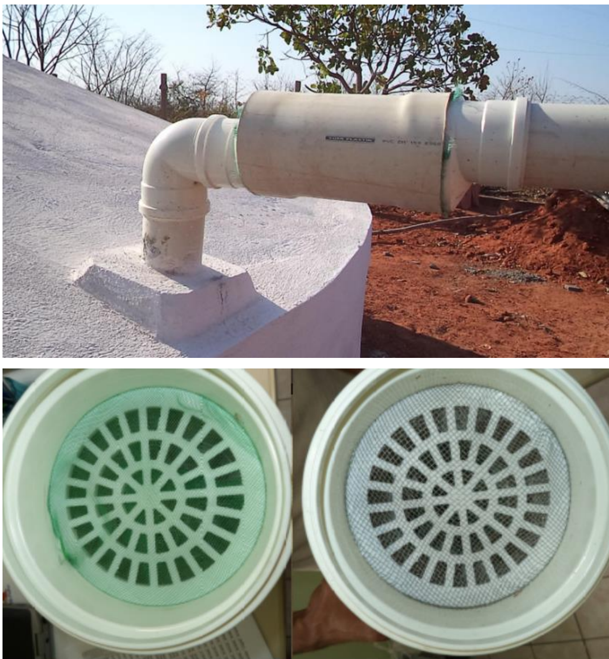
Figura 12: Filtro coador no modelo de PVC e suas reduções
