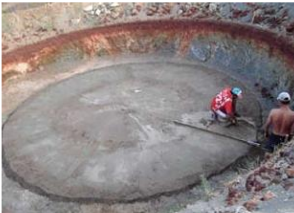
Figura 6: Compactação e nivelamento do fundo do buraco
