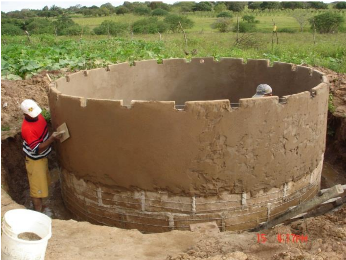
Figura 9: Reboco externo da parede da cisterna
