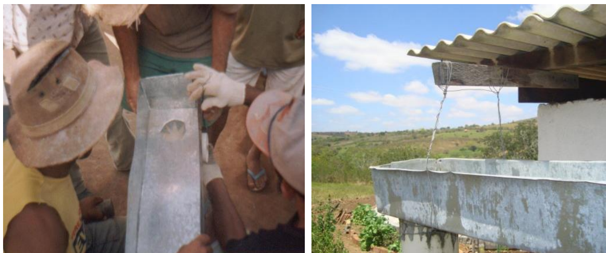
Figura 13: Fixação das calhas de bica
