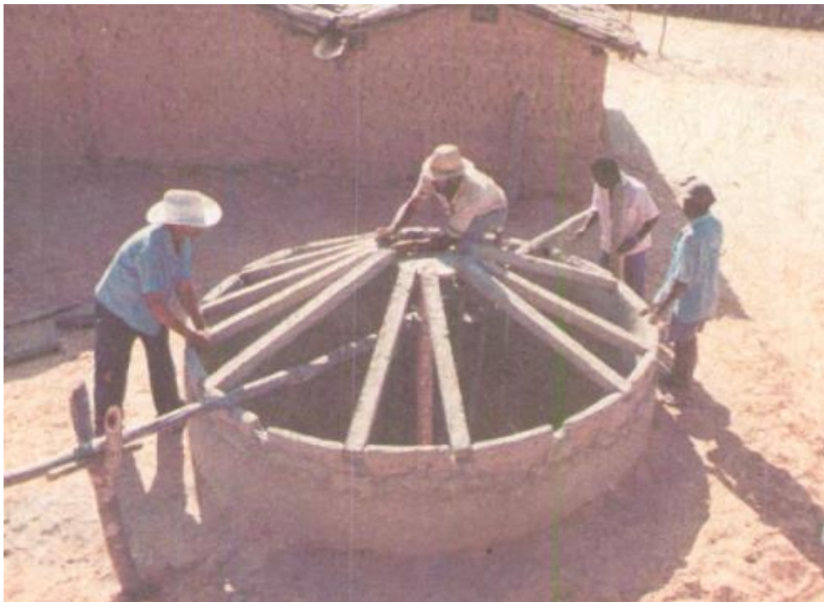
Figura 10: Fixação da escora central e posicionamento dos caibros
