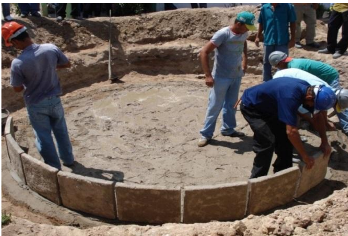
Figura 5: Levantamento da parede da cisterna
