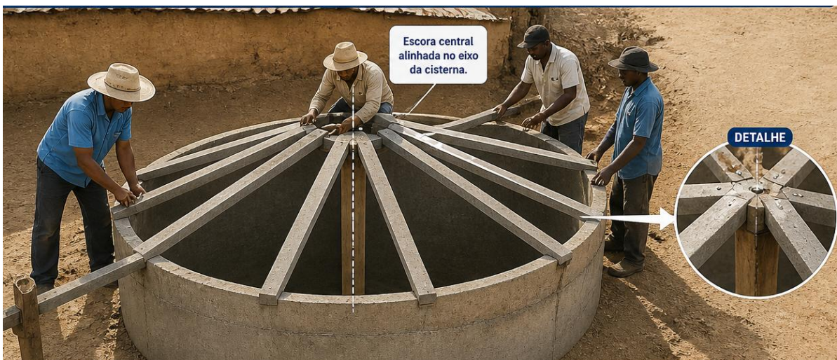
Figura 11: Fixação da escora central e posicionamento dos caibros
