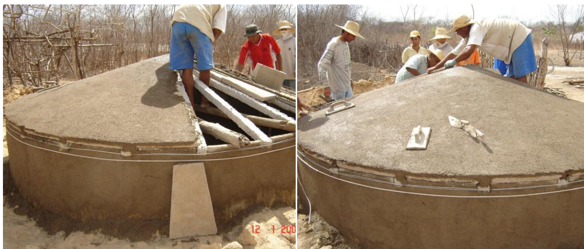
Figura 12: Reboco das placas da cobertura do reservatório
