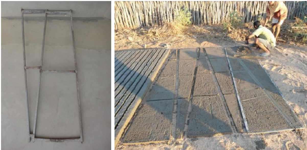
Figura 11: Fixação da escora central e posicionamento dos caibros
