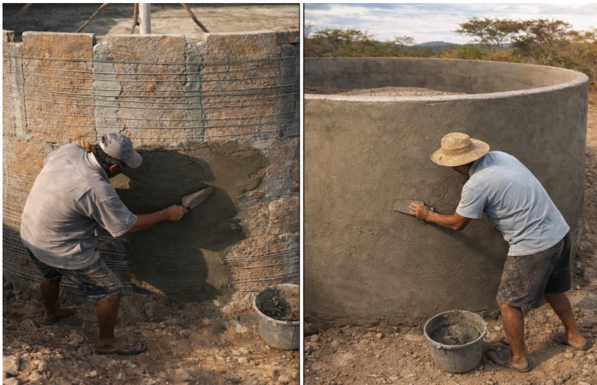
Figura 7: Acabamento da cisterna (amarração, reboco externo e interno)
