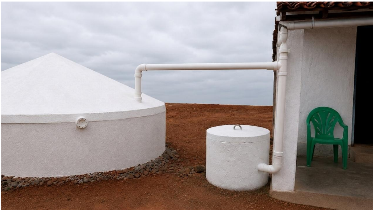
Figura 15: Representação da cisterninha com tampa
