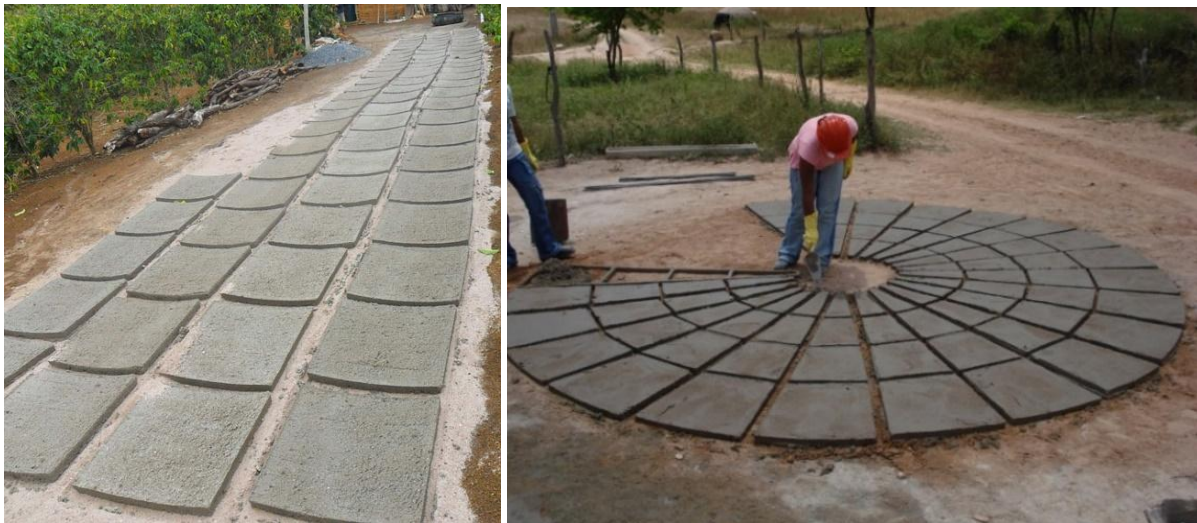
Figura 4: Confeção das placas de concreto
