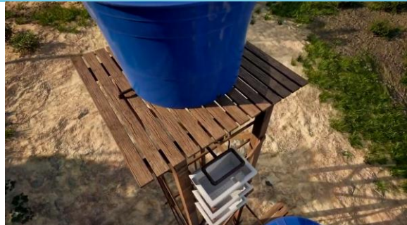
Detalhe do aerador e sistema de tratamento
