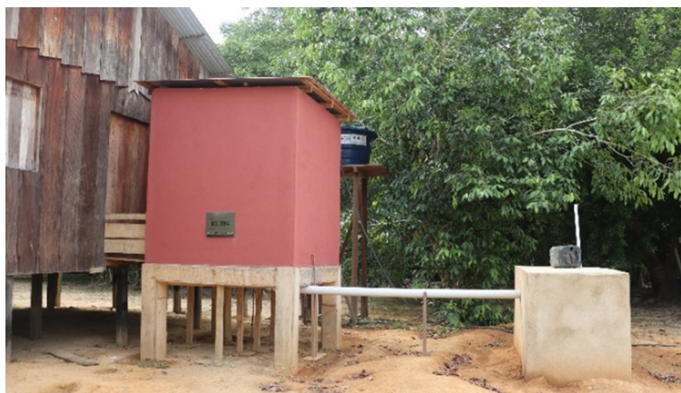
Figura 4: Banheiro (ISD) e fossa de absorção construídos em ambiente de várzea na Amazônia
