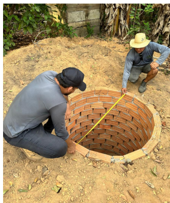
Figura 3: Fossa de absorção em processo de construção
