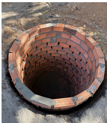
Figura 3: Fossa de absorção em processo de construção
