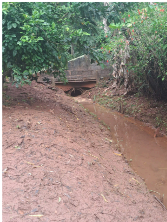
FOTOS 1 e 2: Lançamento pontual de esgoto doméstico in natura a céu aberto, drenando diretamente para o leito do Ribeirão Correias na Comunidade Taboão.
