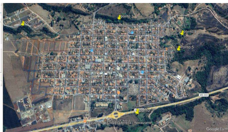
Figura 2- Atuais pontos de lançamento de esgoto in natura nas margens do Ribeirão da Capetinga.
