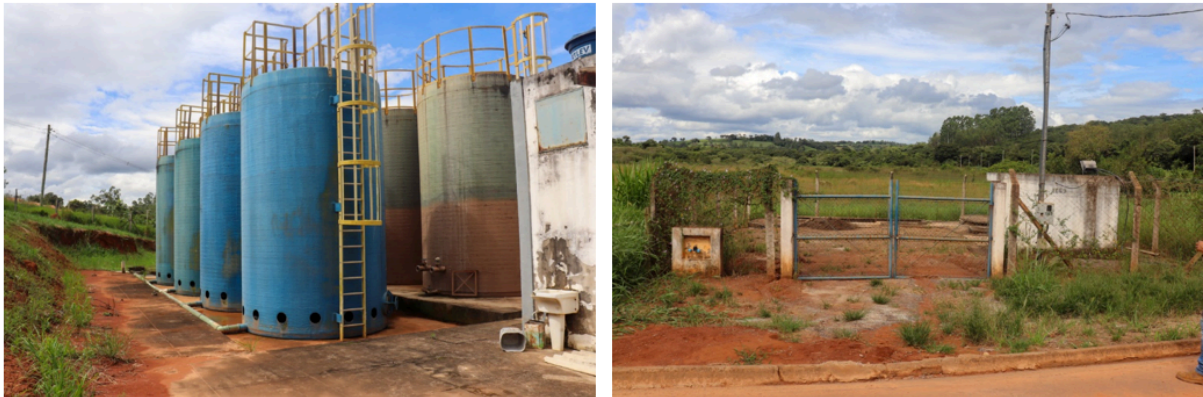
Figura 01 – Vista técnica dos Reatores Anaeróbios de Fluxo Ascendente (UASB) e Estação Elevatória de Esgoto (EEE) da unidade de tratamento de Carvalhópolis/MG.
