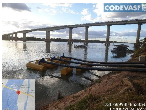
Figura 03: Foto da captação já instalada na etapa 1
