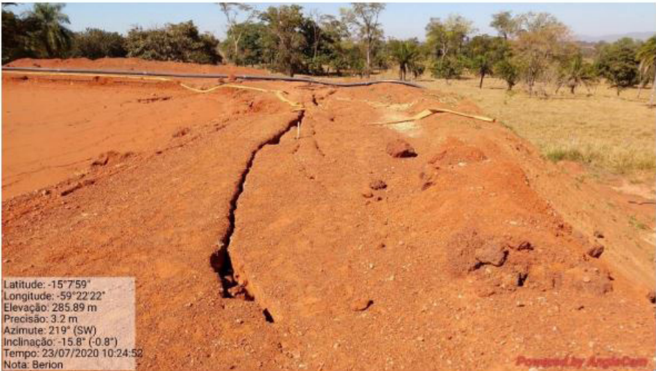
Trincas encontradas na crista da barragem Berion e borda livre insuficiente. Foto: ANM
