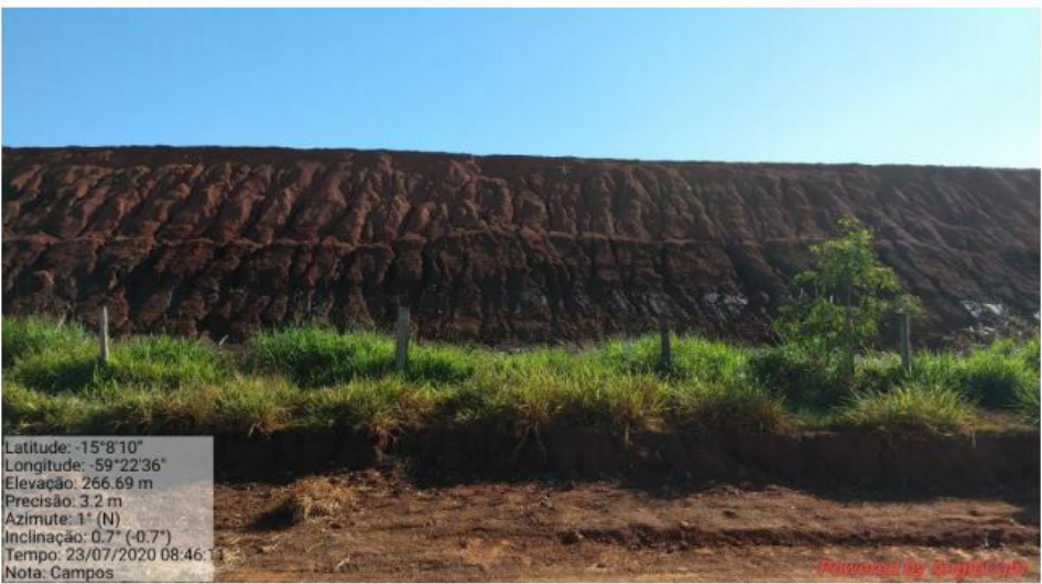
Talude de jusante da barragem Campos com erosões superficiais e destaque para a linha de saturação. / Foto: ANM
