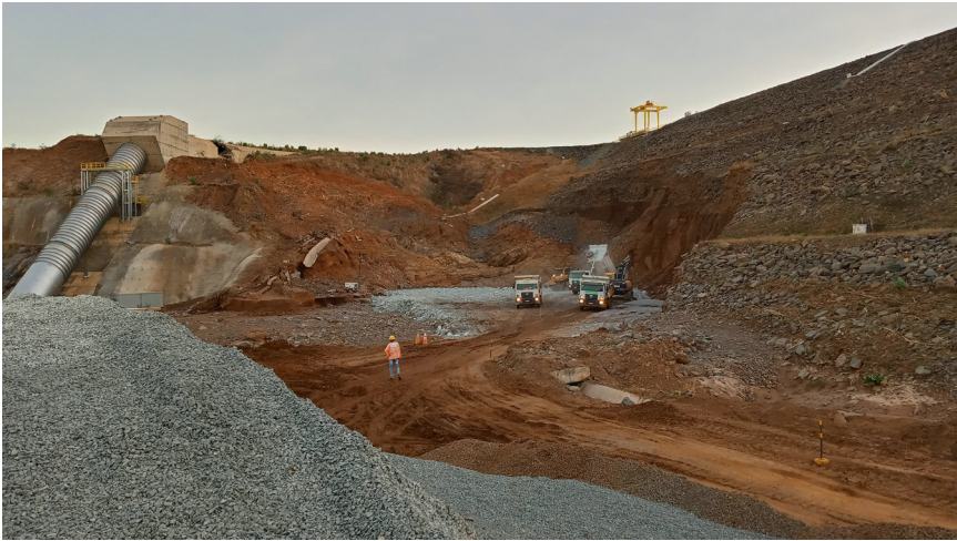
Obras emergenciais na barragem. Foto: SEDEC
