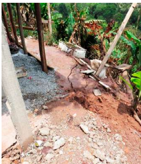
Figura 6. Trinca em edificação próxima da quebra do relevo. Fonte: LabGRis, 2020.
