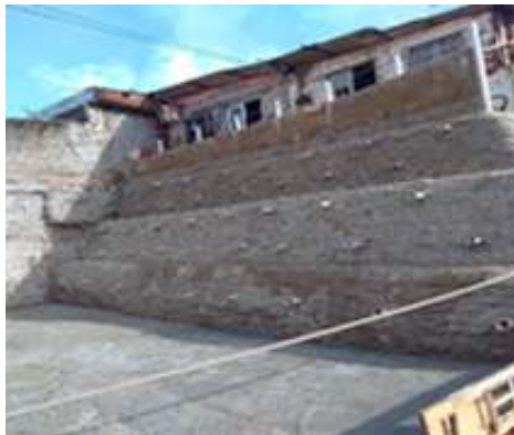
Figura 8. Contenção de encosta em RIP RAP do Programa Parceria no bairro Nova Descoberta, Recife - famílias beneficiadas: 2; custo: R$ 39.591,08; conclusão: 29/04/2020. Fonte: Coordenadoria de Defesa Civil de Recife, 2020.
