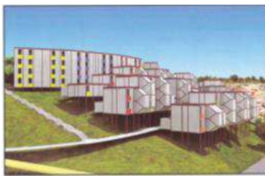
Figura F4: Padrão construtivo em encostas com alta declividade
