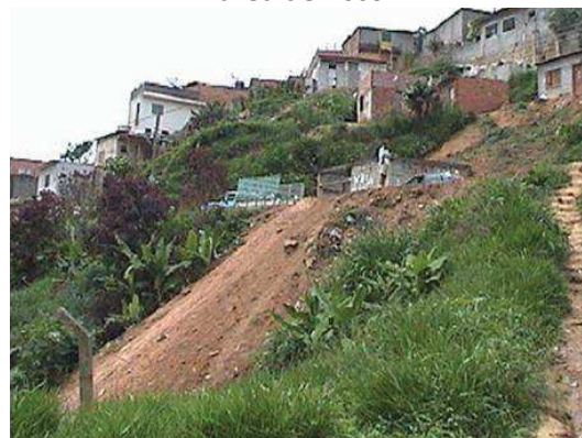
Figura F3: Vista de aterro lançado em encosta de área de risco
