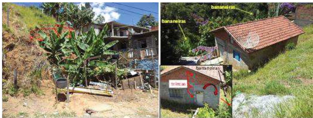
Figura F10: Indícios precursores e deslizamento planar associado ao plantio de bananeiras nas encostas
