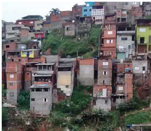
Figura F5: Vista de edificações multipavimentos em área de risco
