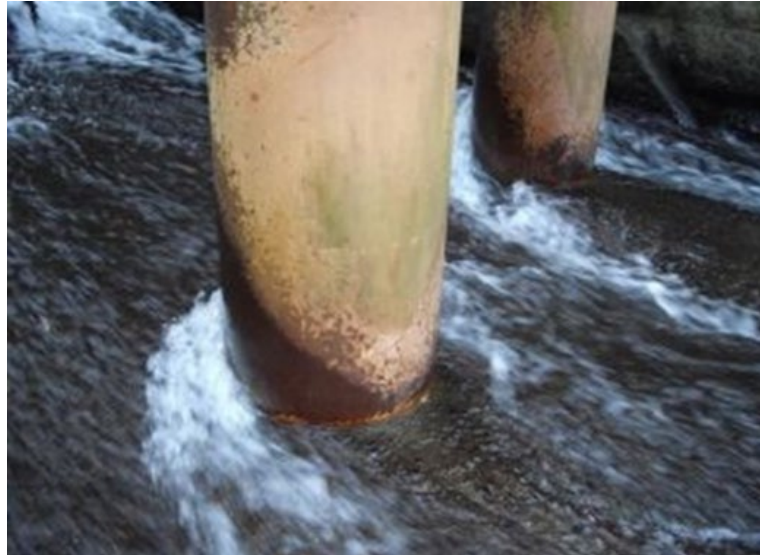
Figura 98 - Superfície do bloco de ancoragem e estrutura de aço, com fluxo constante de água nos períodos de normalidade
