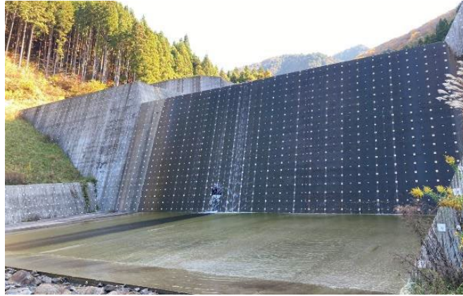
Figura 50 - Calha de dissipação.
