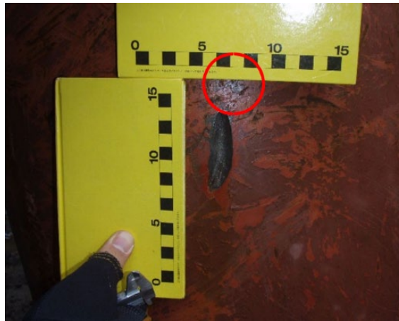
Figura 97 - Ranhuras causadas por blocos na parte mais a montante
