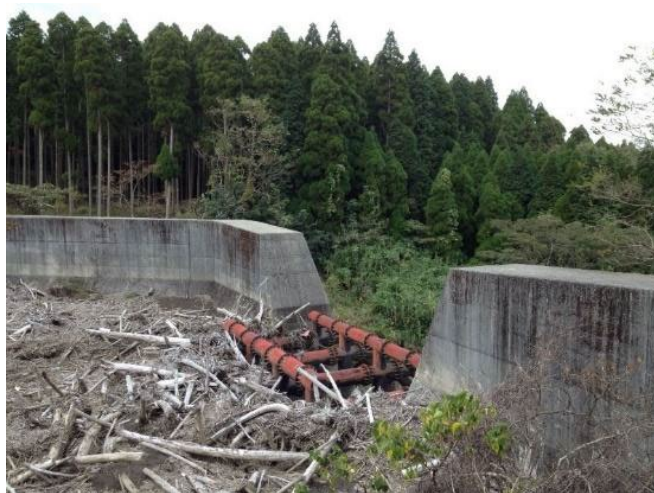
Figura 10 - Topo da estrutura reticulada em aço
