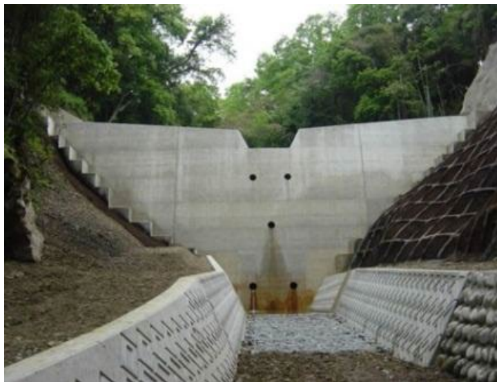
Figura 2 - Barreira impermeável (Concreto)
