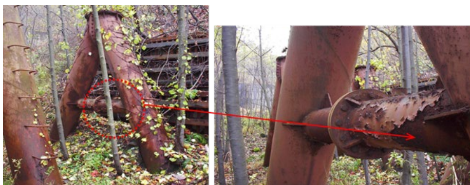
Figura 95 - Barreira Slit No.1, Talvegue 1, Rio Usu (obra concluída em 1979)
