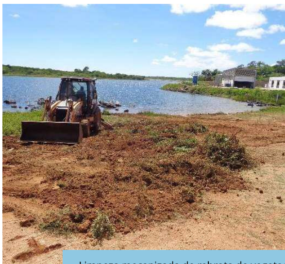
Limpeza mecanizada de rebrota de vegetação na bacia hidráulica do reservatório Moxotó, Trecho V, Eixo Leste do PISF.
