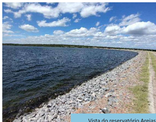
Vista do reservatório Areias (WBS 2104), Trecho V, Eixo Leste do PISF.
