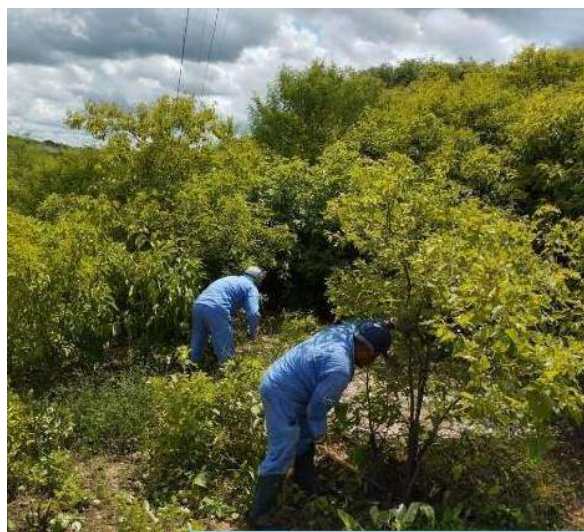
Poda de vegetação sendo realizada na faixa de servidão da LT, entre as torres 24/2 e 25/1, Trecho I, Eixo Norte do PISF.
