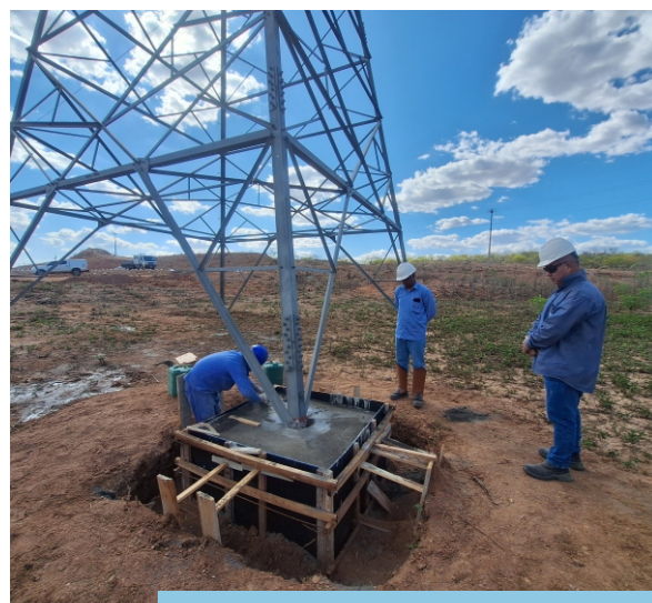
Reforço em estrutura da LT, localizada no entorno do segmento de canal WBS 2212, Trecho V do Eixo Leste do PISF, em Floresta/PE (jan/2026).
