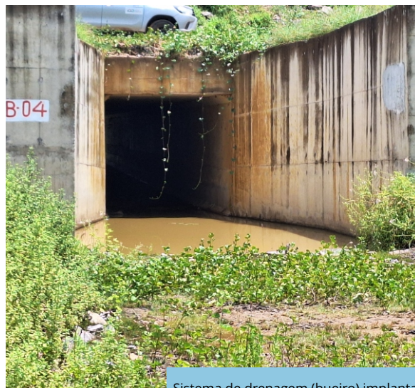
Sistema de drenagem (bueiro) implantado no segmento de canal WBS 1208, Trecho I, Eixo Norte do PISF (abril/2026).
