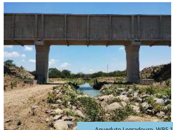
Aqueduto Logradouro, WBS 1305, Trecho I, Eixo Norte do PISF.
