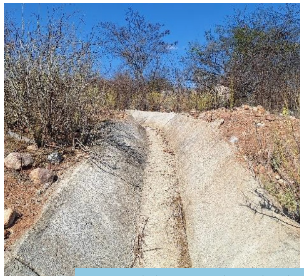
Sistema de drenagem (canaleta) implantado no segmento de canal WBS 2208, Trecho V, Eixo Leste do PISF.
