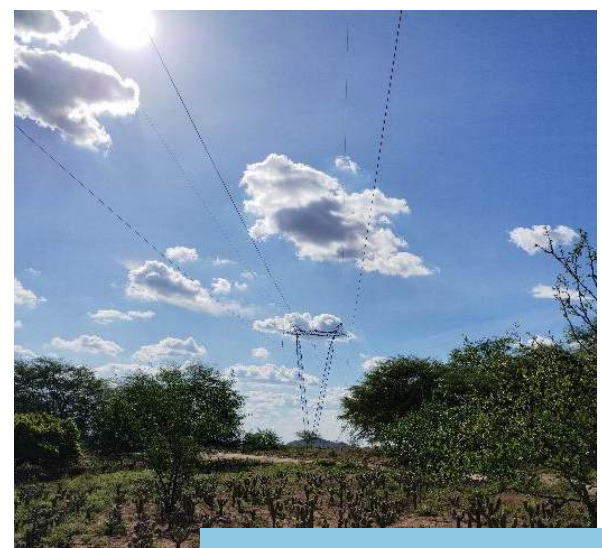
Poda de vegetação realizada na faixa de servidão da LT próximo da EBI-3, Trecho I, Eixo Norte do PISF.
