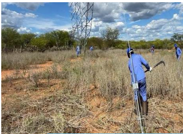
Remoção da cobertura vegetal na base da torre da linha de transmissão de energia elétrica do Trecho V, Eixo Leste do PISF.
