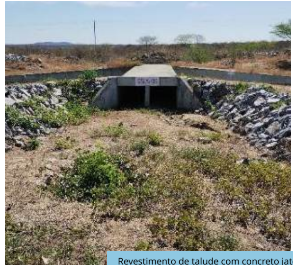
Revestimento de talude com concreto jateado no túnel do segmento de canal WBS 2226, Trecho V, Eixo Leste do PISF.
