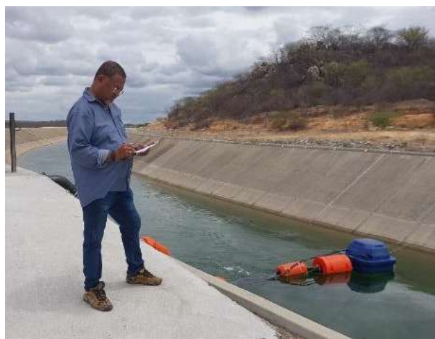
Acompanhamento da implantação das estruturas de captação e adução de água do sistema de irrigação VPR Uri.
