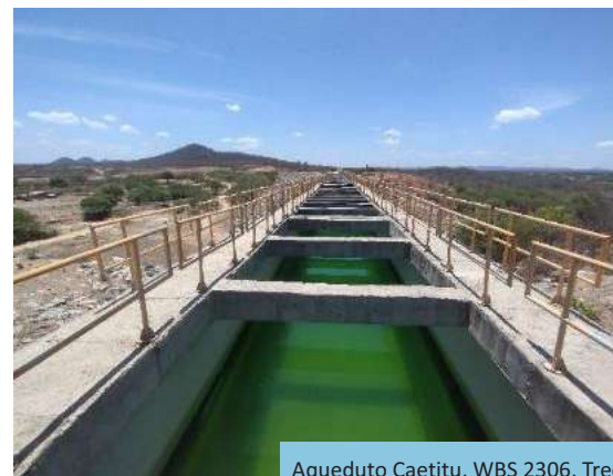
Aqueduto Caetitu, WBS 2306, Trecho V, Eixo Leste do PISF.
