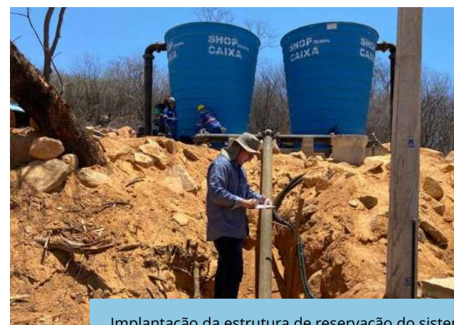
Implantação da estrutura de reservação do sistema de irrigação da VPR Negreiros, Salgueiro/PE.
