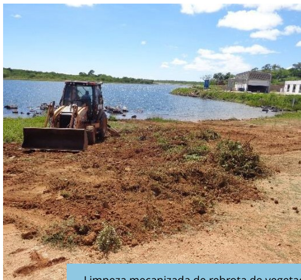
Limpeza mecanizada de rebrota de vegetação na bacia hidráulica do reservatório Moxotó, Trecho V, Eixo Leste do PISF.
