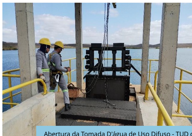
Abertura da Tomada D'água de Uso Difuso - TUD do reservatório Boa Vista, Trecho II, Eixo Norte do PISF (São José de Piranhas - PB).
